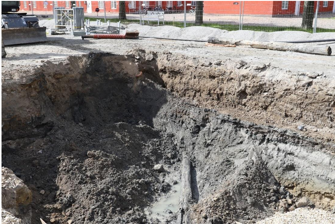
Figur 158 Den NV-SØ-orienterede trævandledning, ST2216 (NV-del) på Kirkepladsen. Set mod NV. Den sydøstlige del er optaget og ligger på jorden. KBM4068_IMG_0727. Københavns Museum
