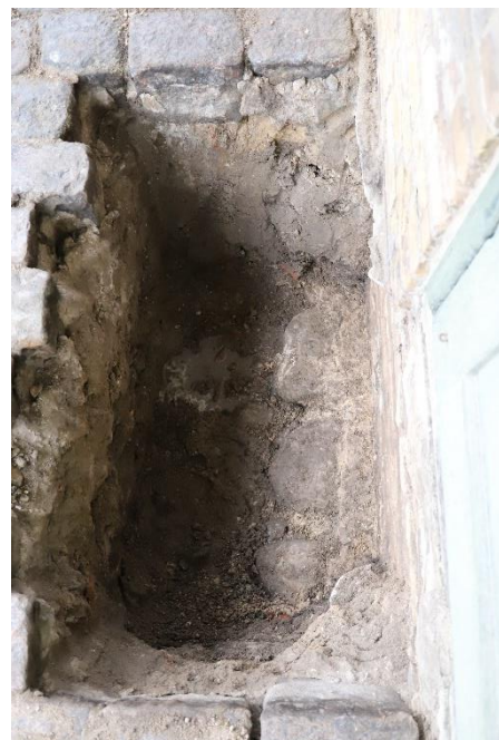
Figur 65 Prøvegravning 43S47/ZT1094 set ovenfra - nord er opad. De store kampesten under teglfundamentet ses i højre side. IMG_KBM4068_0374. Københavns Museum
