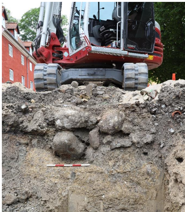
Figur 119 Tværsnit gennem fundamentet til den sydlige mur i slottets SØ-tårn. Set mod vest. KBM4068_IMG_2287. Københavns Museum
