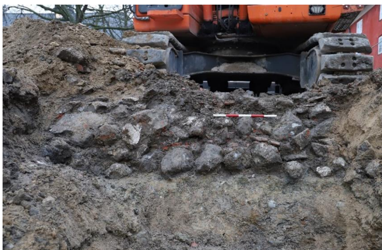
Figur 111 Tværsnit gennem fundamentet til nordvæggen i NØ-fløjen af slottet, SS8093. Set mod vest. KBM4068_IMG_1620. Københavns Museum
