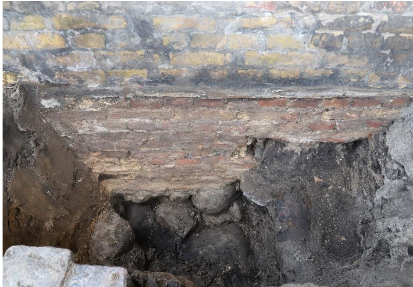
Figur 64 Prøvegravning 43S46/ZT1093, opmuring med tegl under Norgesportens østlige del. Herunder ses kampesten. IMG_KBM4068_0348. Københavns Museum
