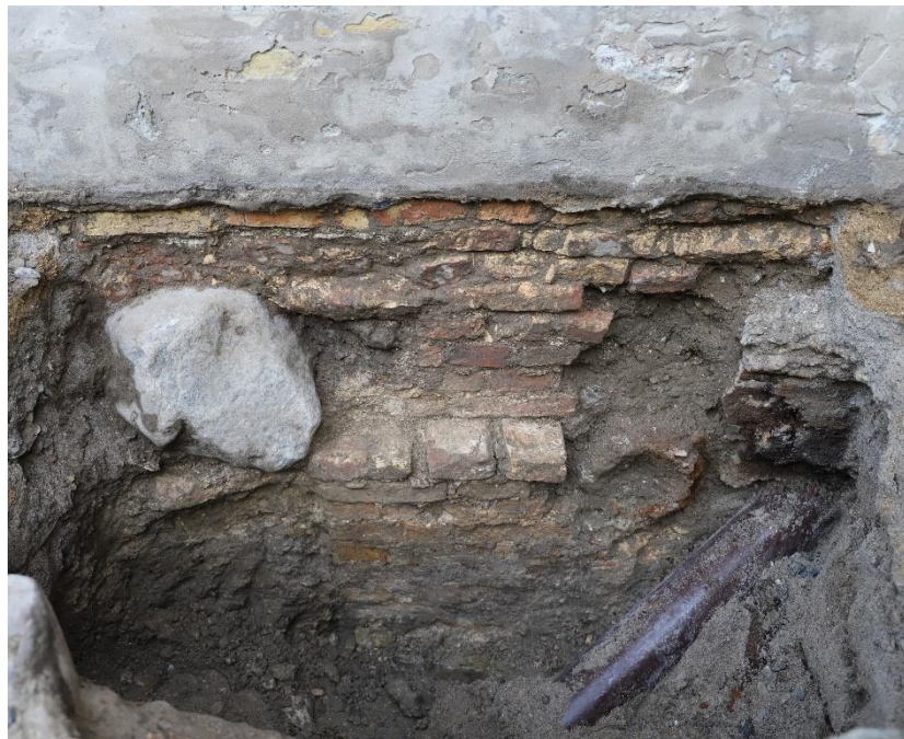
Figur 66 Prøvegravning 45N61/ZT1098 i Kongeporten. De mange forstyrrelser giver næppe et retvisende billede af fundamentets opbygning. Set mod ØNØ. IMG_KBM4068_0363. Københavns Museum
