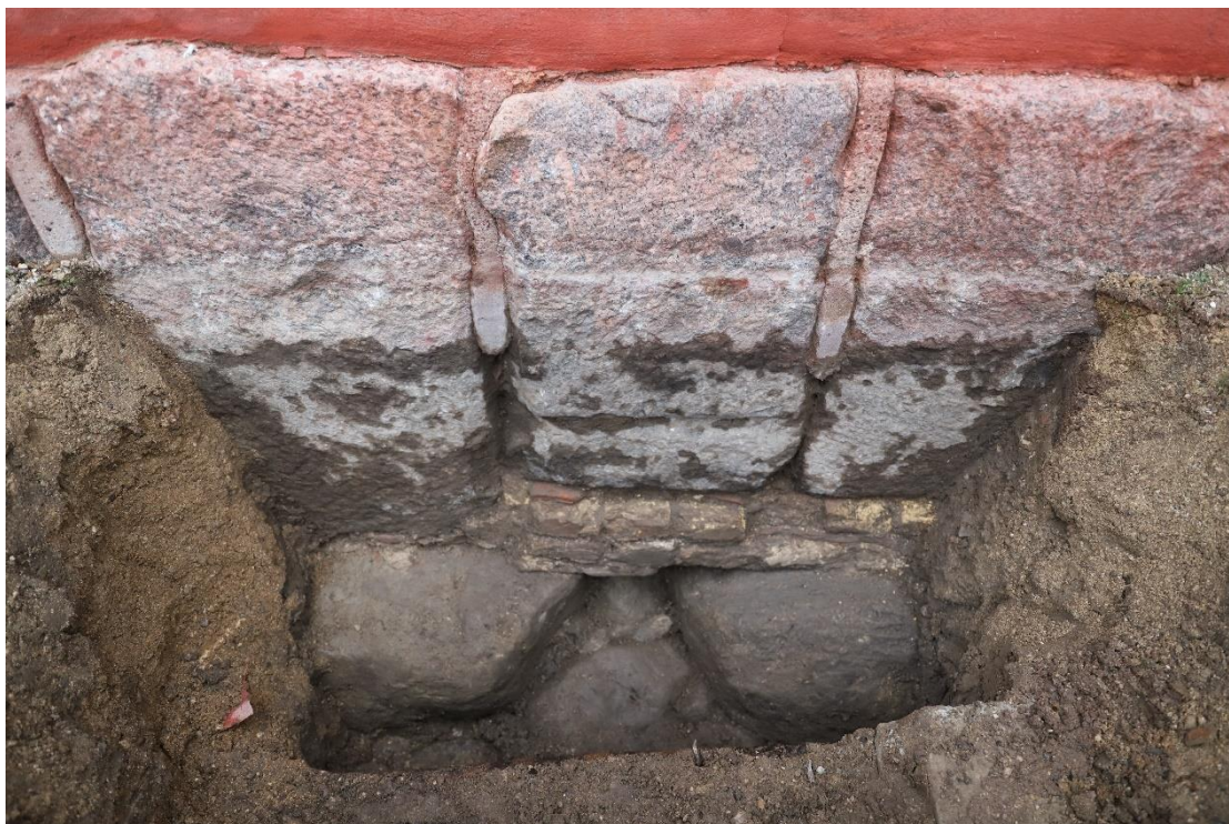
Figur 53 Prøvehul 24S06/ZT1003. Set delvist ovenfra, mod nord. Bemærk de høje, smalle sokkelsten. KBM4068_IMG_0358. Københavns Museum
