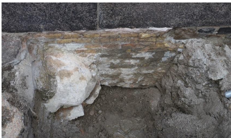
Figur 28 Prøvegravning 04W56/ZT1084, set mod øst. Mindre granitkvadre indsat under sokkelstenen i højre side af billedet. KBM4068_IMG_0314.
