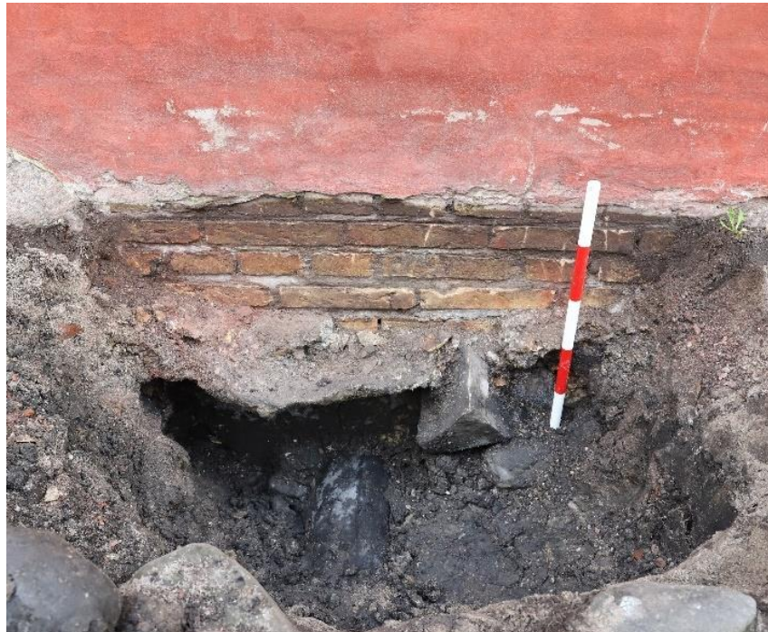
Nordvest for disse prøvehuller blev foretaget en enkelt prøvegravning, 22S09/ZT1090. Her havde man tilsyneladende haft held med at føre en vandinstallation ind mellem to af de store kampesten i muren, så ingen sten syntes fjernet fra dette niveau.
