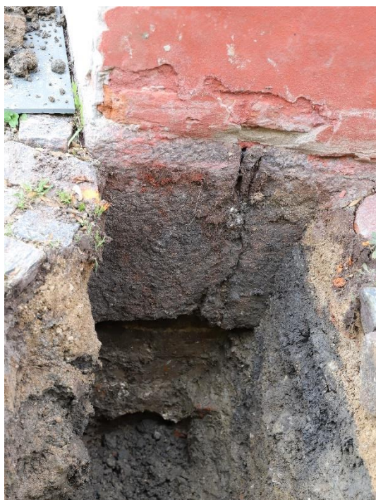
Figur 22 Prøvegravningsfelt 00X64/ZT1008. Vue under kirkens fundament på nordsiden. Set mod syd. KBM4068_IMG_0030. Københavns Museum
