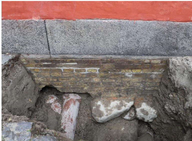
Figur 36 Prøvegravningsfelt 31E20/ZT1013. Set mod vest. Kampestenene i hullets nordlige ende fortsætter mindst 100 cm under sokkelstenens underkant. KBM4068_IMG_0055. Københavns Museum
