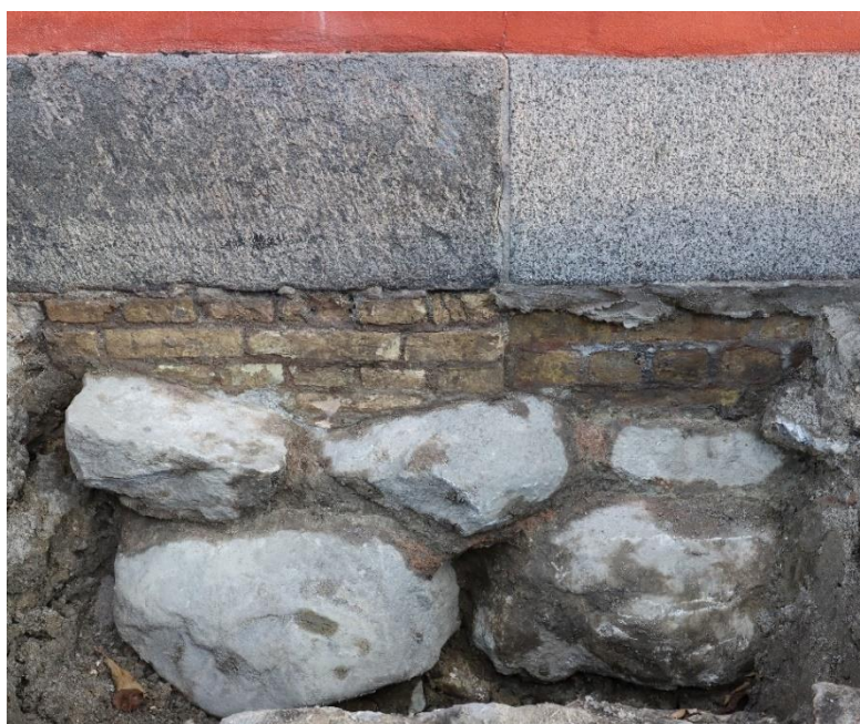
Figur 46 Prøvegravning 39W48/ZT1073 nær Fortunstoks nordende, set mod øst. Bemærk ændringen af teglstensopbygningen ca. midt for. KBM4068_IMG_0254. Københavns Museum
