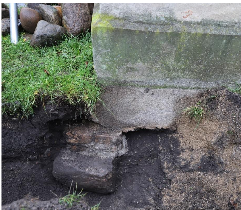
Figur 62 Tidligere fundament under Sprøjtehusets NØ-hjørne. Set mod syd. IMG_KBM4068_0246. Københavns Museum
