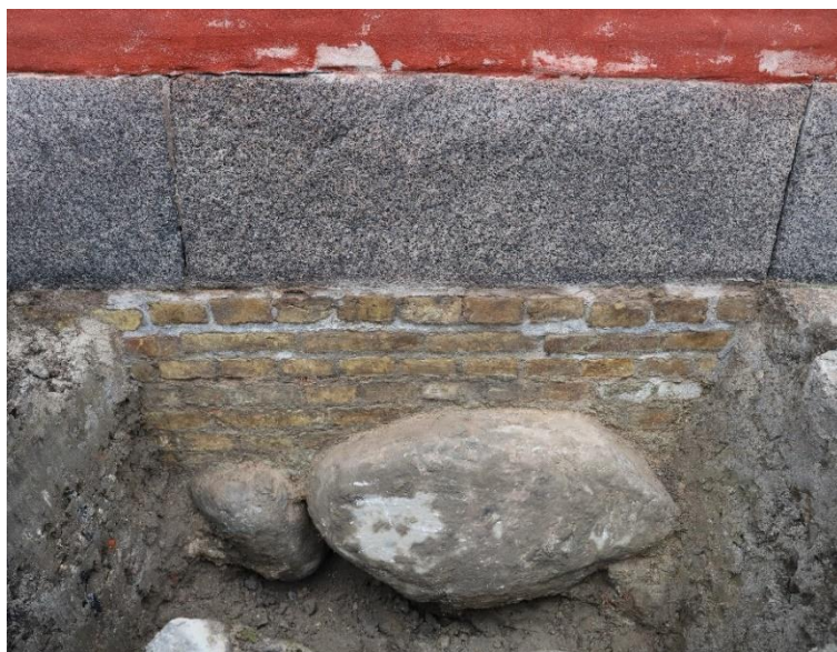
Figur 27 Prøvegravning 04 W 57 / ZT1085, set mod øst. Teglene i det øverste skifte af større dimensioner end de øvrige tegl. KBM4068_IMG_0312. Københavns Museum
