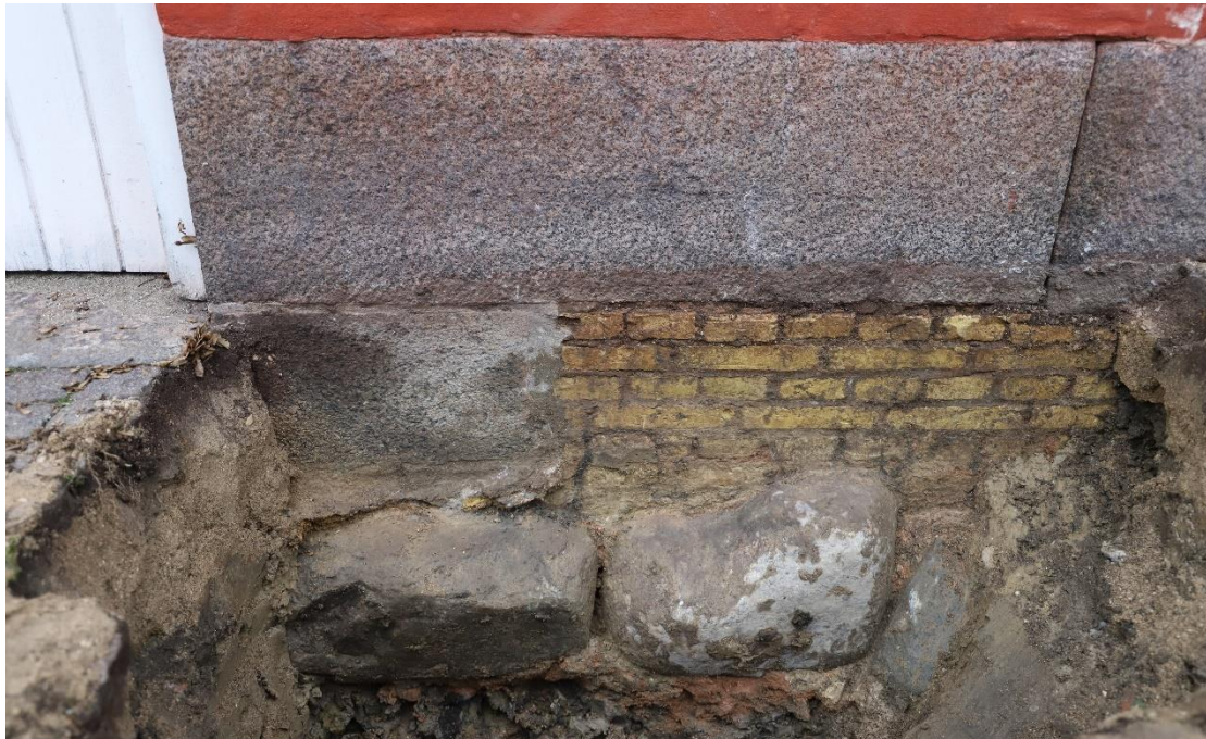
Figur 34 Prøvegravning 21V19/ZT1051, set mod øst. Bemærk granitkvaderstenen øverst til venstre i fundamentet. KBM4068_IMG_0181. Københavns Museum
