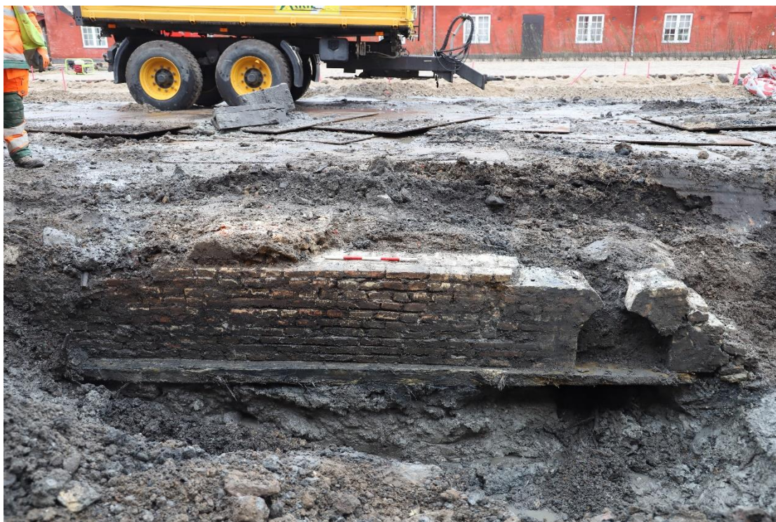
Figur 238 Den sydligst erkendte del af SG200088. Teglfundamentet SS8654 med en hvælving i sydenden og plankebunden ST8674. Set mod øst. KBM4068_IMG_1703. Københavns Museum
