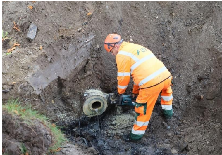
Figur 173 Arbejdsfoto: Der udsaves en prøve af trævandrøret ST5020. Set mod VNV. KBM4068_IMG_1160. Københavns Museum
