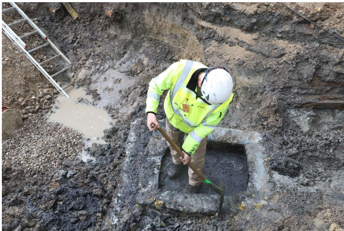
Figur 212 Arbejdsfoto: Den teglbyggede struktur SS5971 oven på betonpladen SS5975. Set delvist ovenfra, nord er opad. KBM4068_IMG_1347. Københavns Museum
