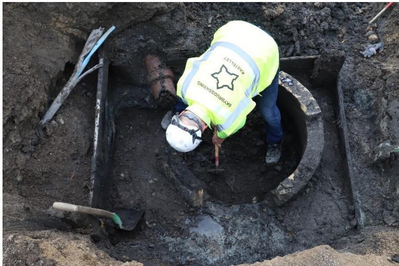
Figur 211 Arbejdsfoto: Den teglbyggede ring, SS5734 i den tømmerbyggede kasse ST5750, set delvist ovenfra. Vest er opad. KBM4068_IMG_1300. Københavns Museum
