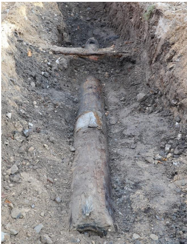
Figur 175 Trævandrør ST6588 med blyplade (nærmest) og hul (øverst i billedet). Set mod øst. KBM4068_IMG_1548. Københavns Museum
