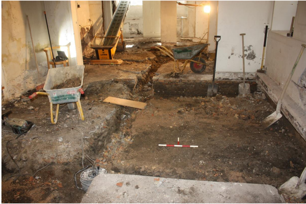
Fig. 11. Betongulv og brokkelag bliver fjernet, set fra nordvest. Foto: nr. 1878 i fotolisten.
