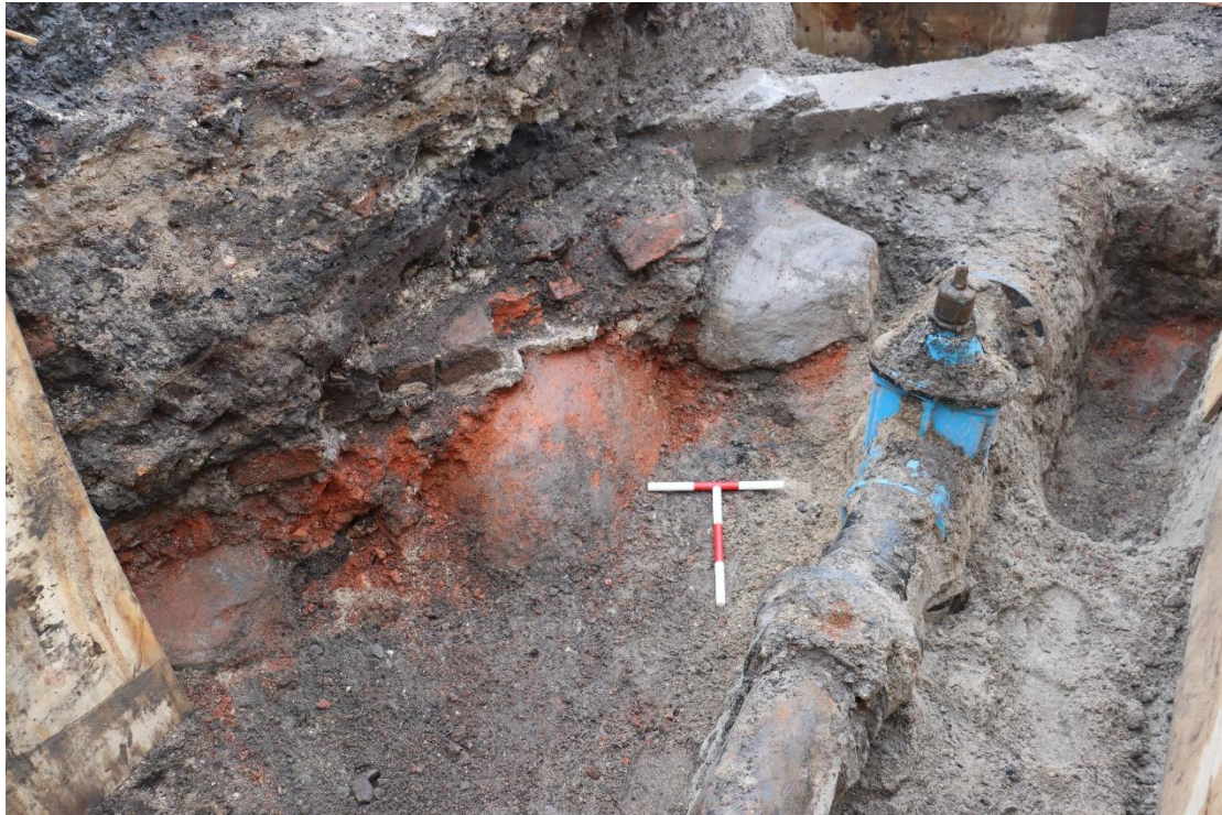
Figur 13. IMG_0550: I200036. Kampestenene: SS1079, SS1088. Kulturlagsrest: SD1109 og sættelag/funderingslag: SD1067. Københavns Museum .
