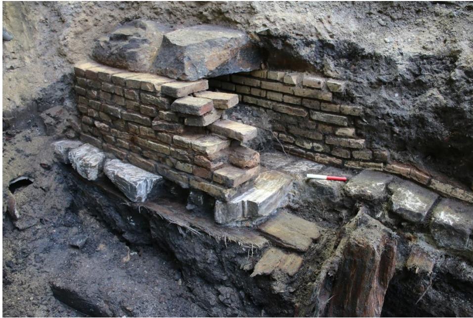
Figur 8. Nærbillede af kloakken (kuvert) med tydelig opbygning. Foto: Københavns Museum.
