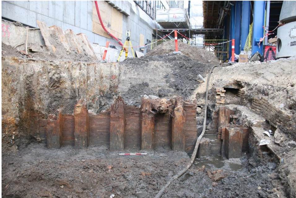
Figur 22. Plankevæg bolværk set fra nordvest. Foto: Københavns Museum.
