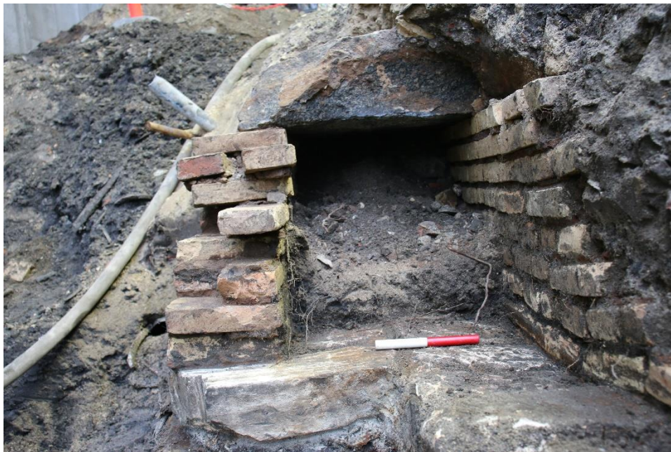
Figur 7. Kloak ( kulvert ), indhold. Set fra nordvest. Foto: Københavns Museum.
