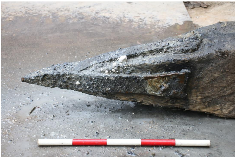
Figur 25. Tilspidset bolværkspæl med jernspids som forstærkning. Der var kun enkelte af pælene der havde forstærkning. Dette kunne tyde på at de var genanvendte. Brug af genanvendte materialer er ikke usædvanligt i bolværker. Foto: Københavns Museum.
