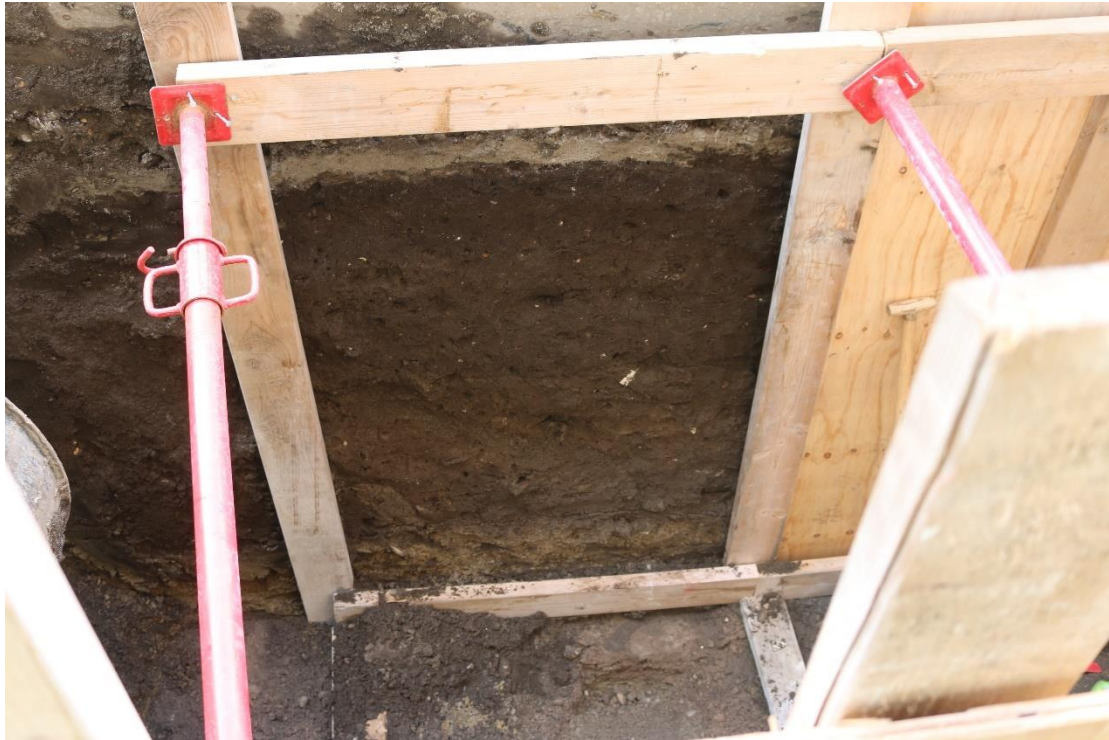
Figur 7: Store, brune, muldede opfyldslag oven på mere leret opfyld. Her kan det ses, at de er ca. 125cm tykke, og ligger mellem de nuværende vejlag og det gule lerede opfyld under (Foto 7483, kamera 31).
