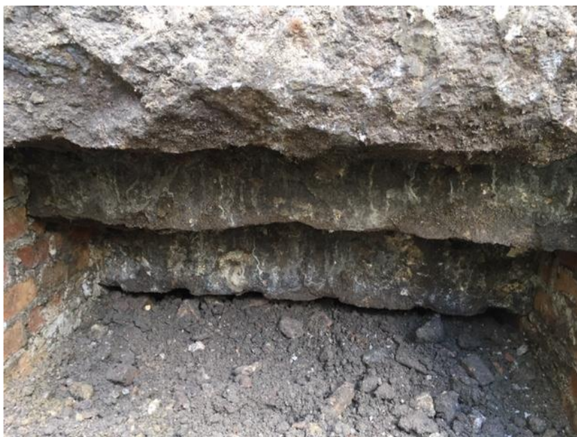
Fig. 10. A1 i nærbillede. Øverst ses granitoverlægger og herunder lofts konstruktion bestående af to forskudte "omvendte trin" bygget af gule teglsten. Foto: C. Seehusen, Københavns Museum.
