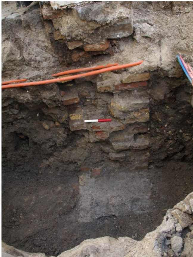
Fig. 13. Murfundament A3 under nuværende portmur. Foto: C. Seehusen, Københavns Museum.
