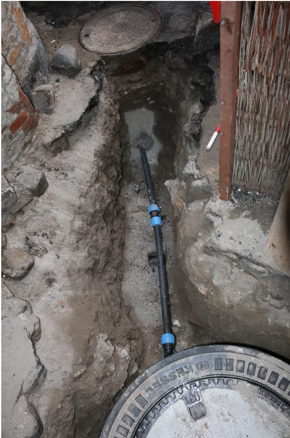
Figur 47: Grøft ZT5033, den berørte kun nogle brokkelag i toppen og var ikke mere en godt 40 cm dyb. Foto: IMG_7728, Københavns Museum.
