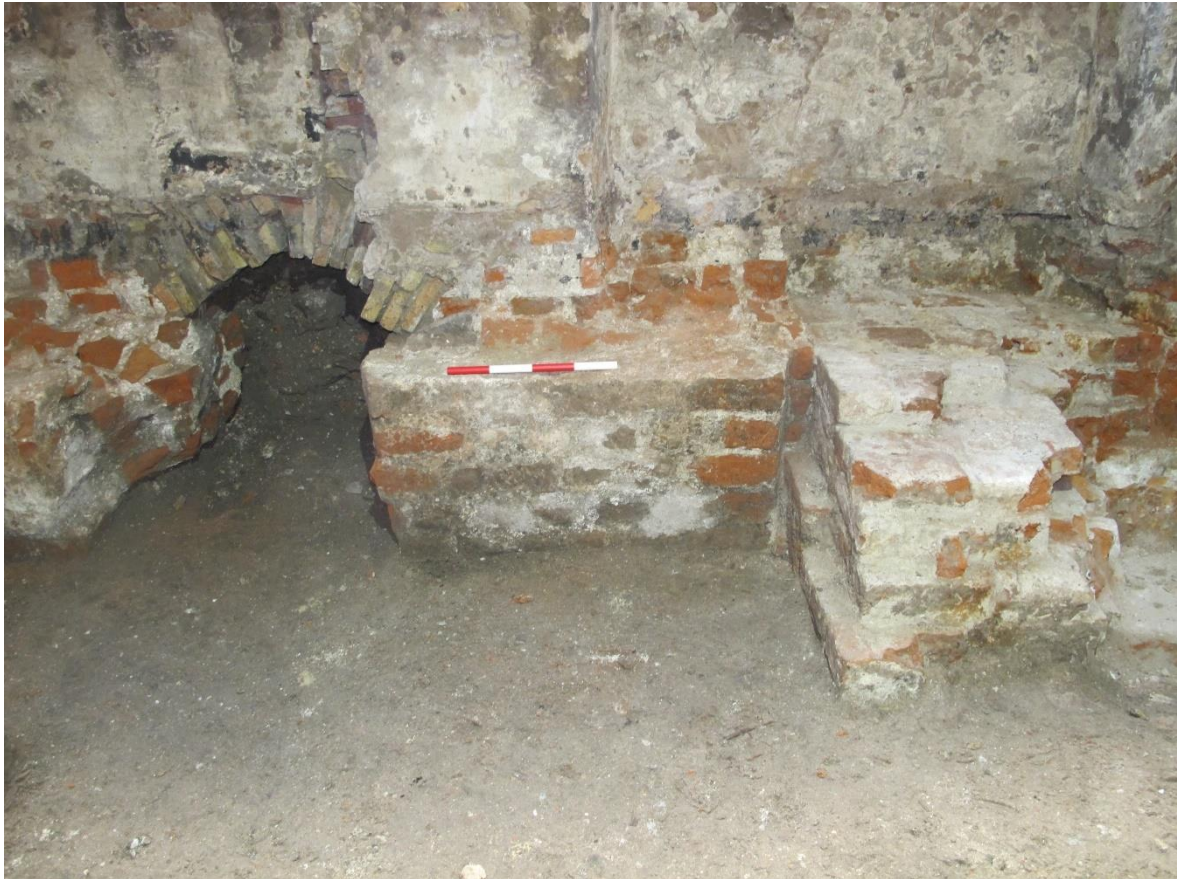
Figur 12: Murværk SS119, SS120 og til højre SS121. Det er værd at lægge mærke til hvælvingen til venstre, der nok i 1700-tallet er ført igennem bygningen til et trævandværk. Denne må være løbet igennem den kælder, der kan have været på stedet, men det rejser spørgsmålet om, hvornår kælderen må være sløjfet. Foto: IMG_0003, Københavns Museum.
