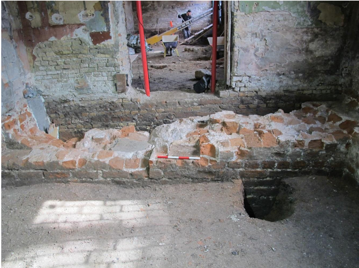
Figur 11: Murværket SS118. Ved fotostokken ses en af blindingerne der har båret en træbjælke. Foto: IMG_0009, Københavns Museum.
