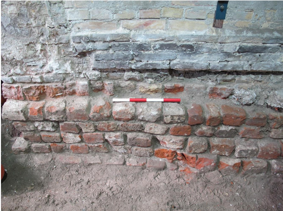
Figur 13: Murværket SS121, der består af genbrugte munkesten. Foto: img_0018, Københavns Museum.
