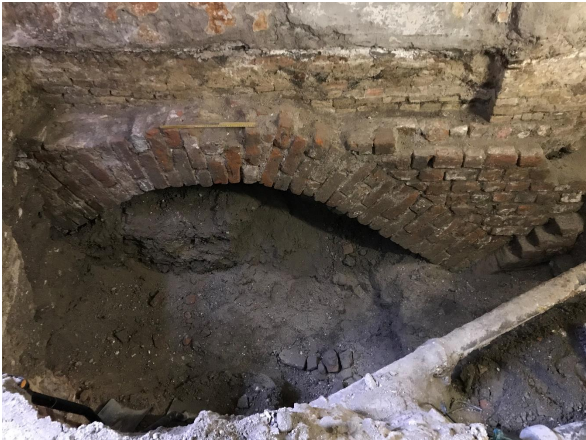
Figur 29: Aflastningsbuen SS5003 i sin helhed som den blev gravet ud. Den har formentlig båret en større mur ovenpå. Foto: IMG_0155. Københavns Museum.
