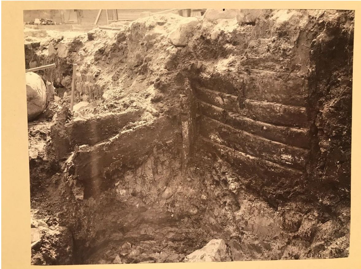
Figur 46: Latrinkonstruktion fundet i 1906 af H.N. Rosenkjær på Vimmelskaftegade, mellem Klosterstræde og Valkendorfsvej. Plankerne til højre er ligeledes genbrugte skibsplanke med kalfatring i mellem. Kilde: Topografisk arkiv, Københavns Museum.
