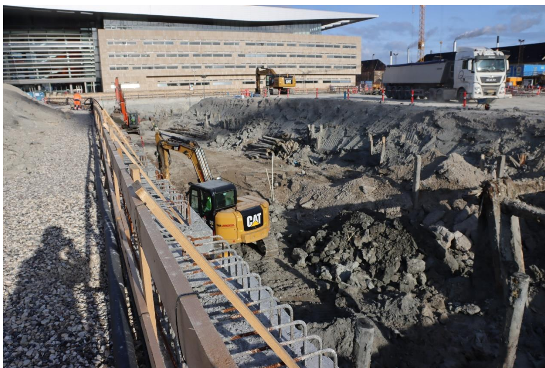
Figur 7: Foto af inderfladen "Niveau 1" under afgravning, med den støbte D-Wall i forgrunden.
