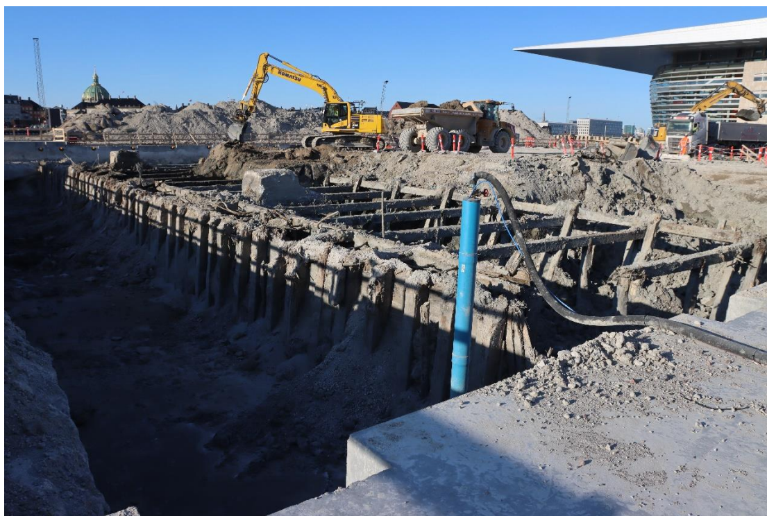
Figur 9: Foto af bolværket under frilæggelsen.
