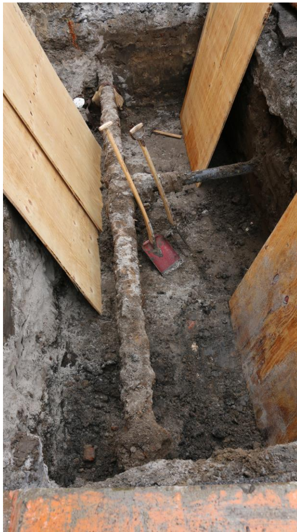
Figur 12. Grøften i Store Kannikestræde, hvor opfyldslaget S100036 var forstyrret af en gasledning. Formentlig er der gode bevaringsforhold i en større dybde. Foto KM.
