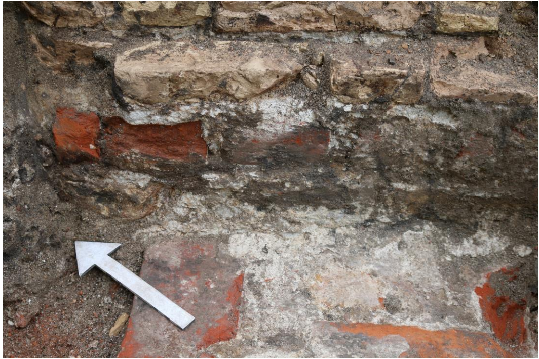
Figur 8. Detalje af S1463 med bevarede mobber mellem munkestenene. Set fra N. Foto: KM.
