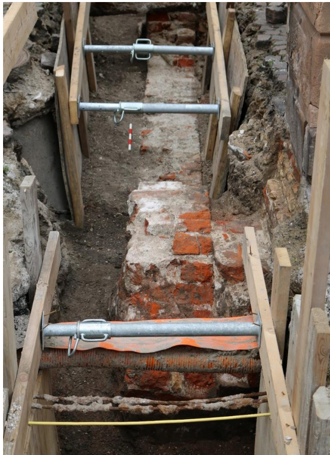
Figur 9. Murforløbet S1463 set fra Fiolstræde og igennem porten ind til baggården ved metropolitanskolen. Bemærk den fjernede sektion af muren i den øverste halvdel af billedet. Dette er sket i ved en tidligere lejlighed og ikke i forbindelse med den aktuelle undersøgelse. Set fra SV. Foto: KM
