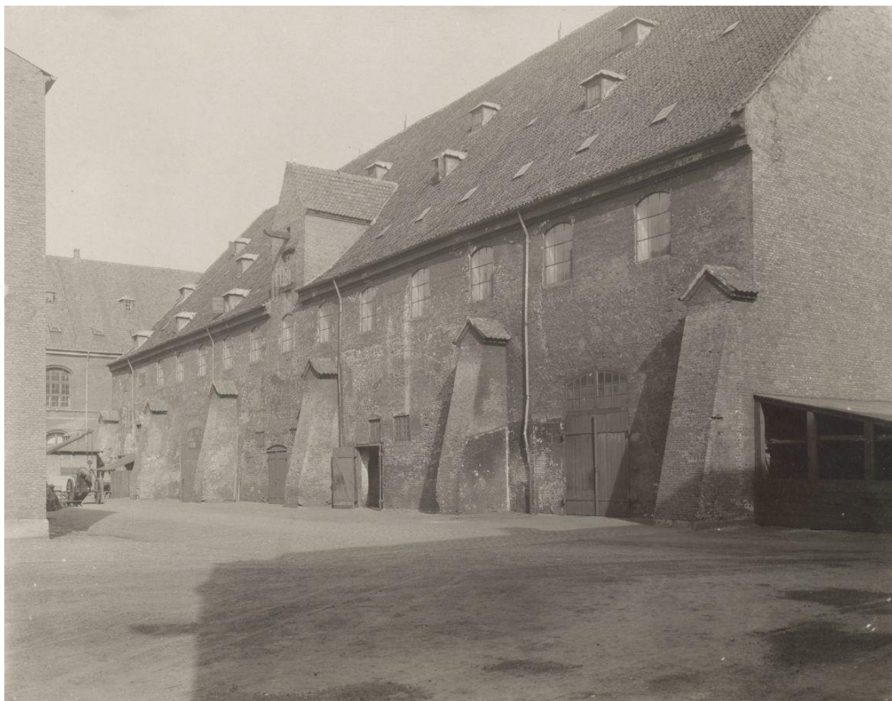
Figur 9. Nordsiden av Galejhuset med aktuelle støttepilarer sett fra vest. De aktuelle og undersøkte murverkene utgjør troligvis støttepilar nr. 2 og 3 sett fra venstre. Christian IV's galejhus. Hentet fra https://kbhbilleder.dk/kbh-museum/84530 den 2021-07-15.
