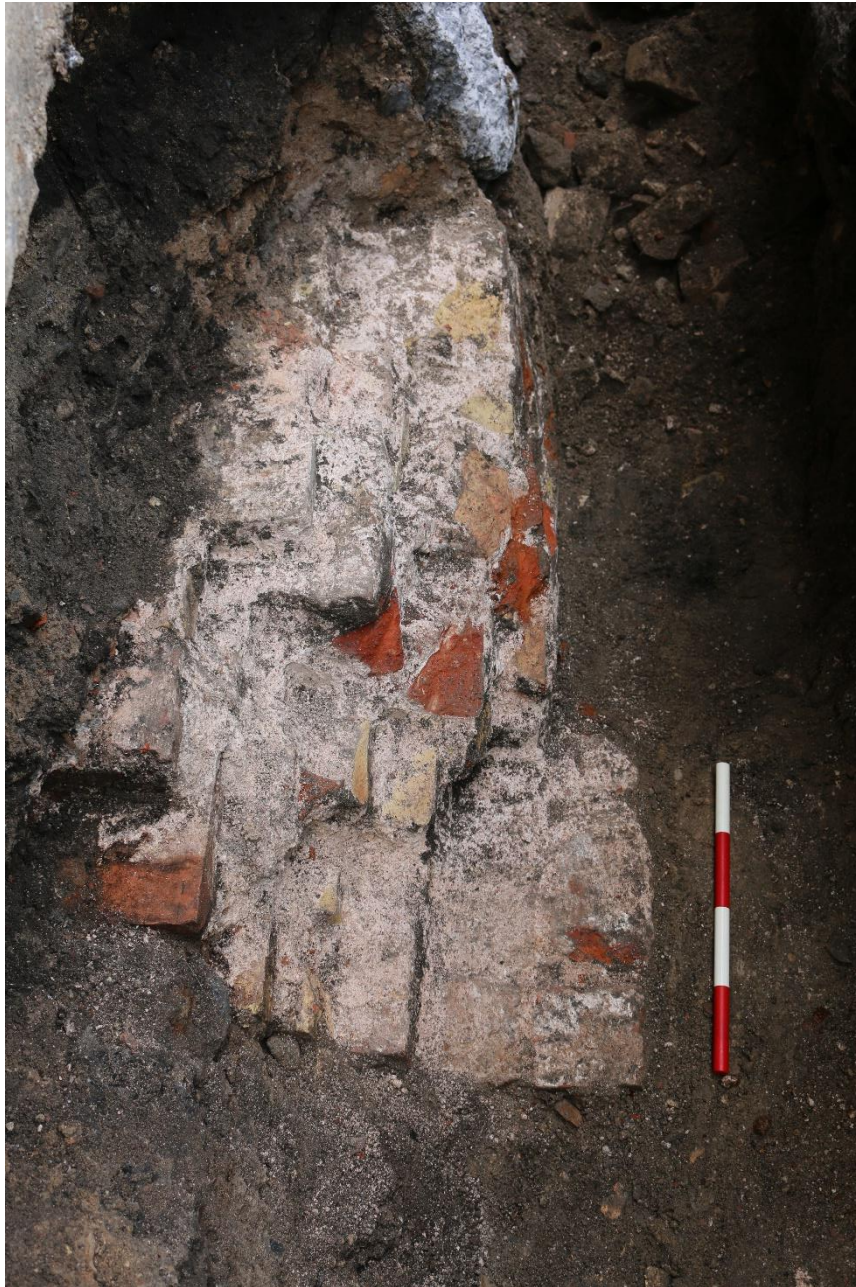
Figur 8. Eksponert murverk (S200004) beliggende vinkelrett og integrert i grunnmuren til Det Kongelige Bibliotek sett fra NV. Foto: Københavns Museum.
