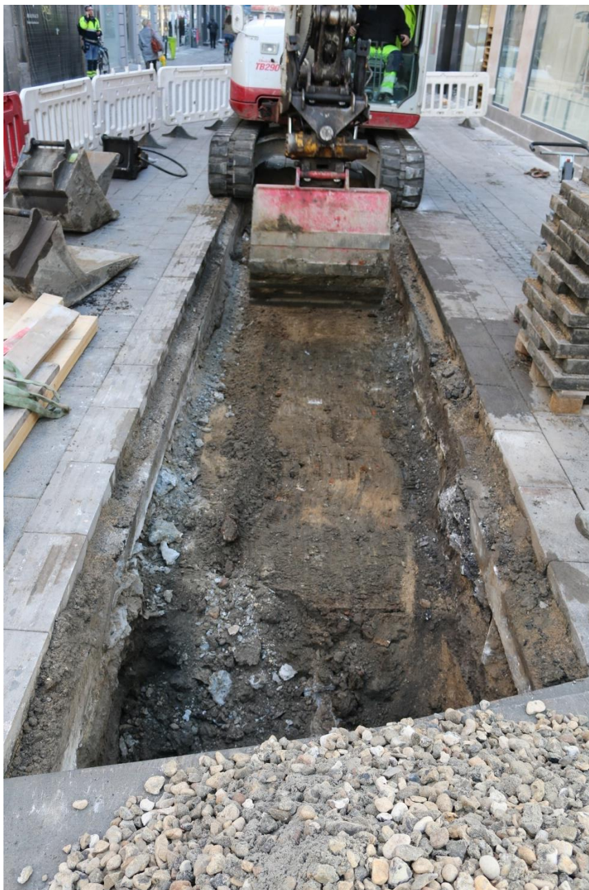
Figur 45. Grøft ZT100048 nord for Frederiksbergsgade nr. 11A sett mot NØ. Foto: Københavns Museum.
