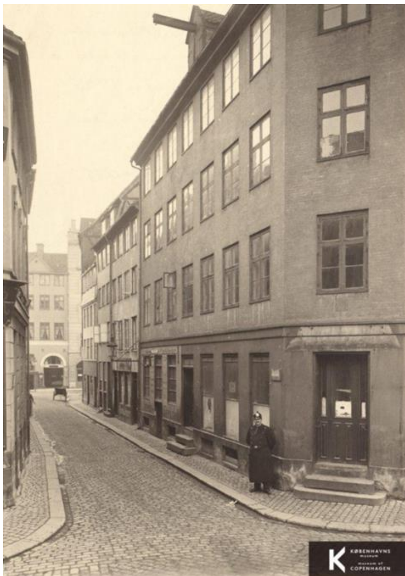
Figur 69. Gåsegades sydvästra fasad sett från Kompagnistræde, ca. 1905. Lägga märke till det brutna hörnet, vilket har tolkats som vägg SS100333. Fra https://kbhbilleder.dk/kbh-museum/84138 Hentet den 2020-05-09.
