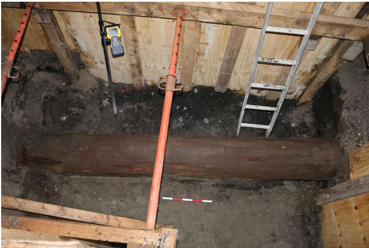
Figur 18. Trevannrør (ST1006) i hovedgrøft ZT1000 in situ sett mot NV. Foto: Københavns Museum.
