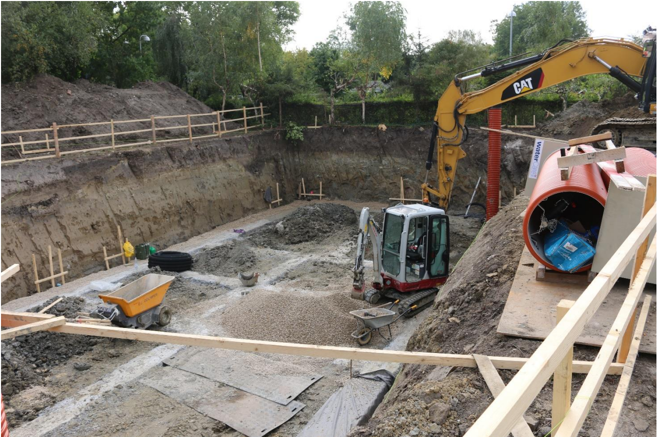
Figur 2. Byggegrøp for kommende husgrunn på Jyllandsvej nr. 29, Fredriksberg Kommune. En av de aktuelle gropene ses i nedgravningskanten i midten av bildet. Foto: Københavns Museum.
