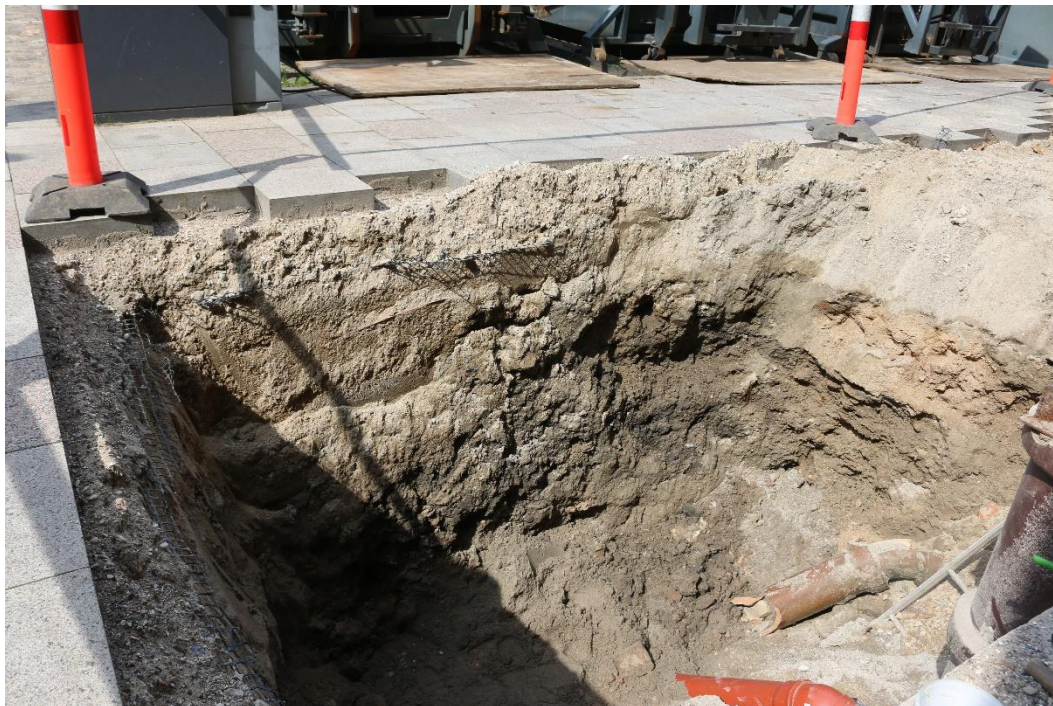
Fig. 12 Hullet mod SV – her ses det opblandede fyldlag der indeholdt teglsten og brokker, samt et fåtal af dyrekogler.
