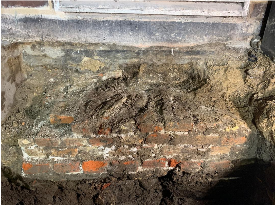
Figur 4. Tegelmur S200003 mot NV.
