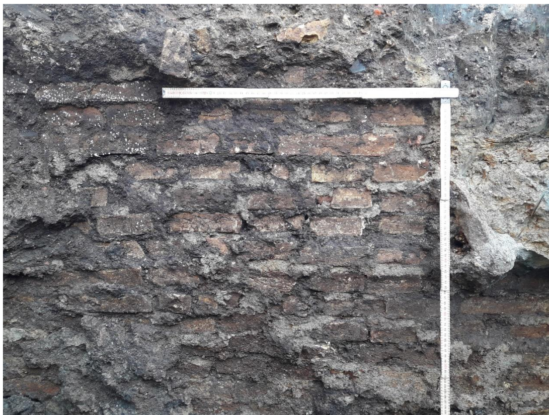
Fig. 12. Teglstenskonstruktion set i grøftens profil. Der er sandsynligvis tale om ydervæggen af et muret latrin, som der er udgravet flere af i forbindelse med udgravningen KBM4340.
