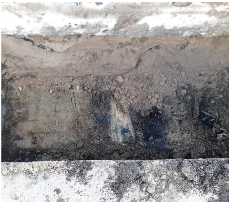
Fig. 12. Et trævandør blev registreret i 1,15 meters dybde på tværs af grøften, der blev gravet langs Kronprinsessegade.
