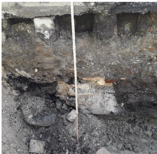
Fig. 11. Del af fundament fra 16-1700-tallet, 3 teglsten bredt og 10 sten højt.
