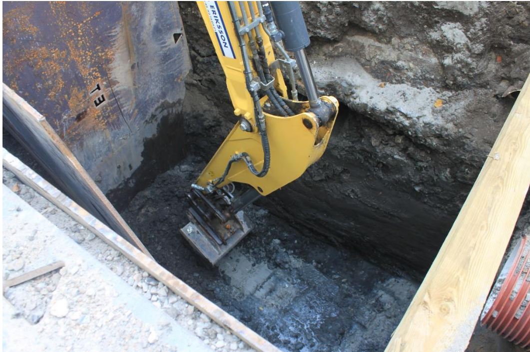
Fig. 18. Bund af grøften, og bund af kanalfyldet, 3,5 m ned fra gadeniveau. Der var meget vådt i bunden, og en pumpe måtte sættes ned senere. Set fra NV. (Foto nr. 90 i fotolisten)
