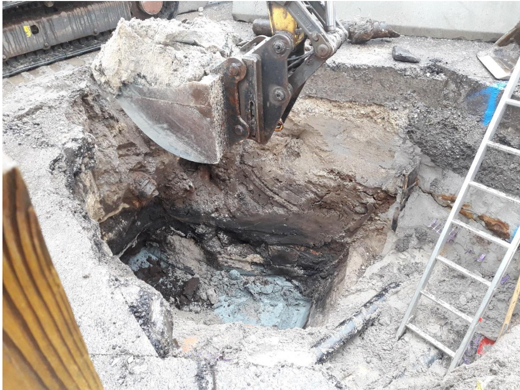
Fig. 15. En brønd graves ned i hjørnet af grøften i krydset Bredgade/Frederiksgade. Blåler kommer ved en dybde af 2,2 m. Set fra NØ. (Foto nr. 49 i fotolisten)
