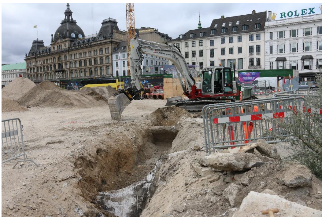
Fig. 15. Bunker SM1731. (Foto nr. 232 i fotolisten)
