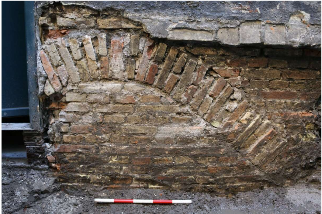
Figur 6. Aflastningsbue af gule hollandske mopper set mod NØ. Foto: Københavns Museum.
