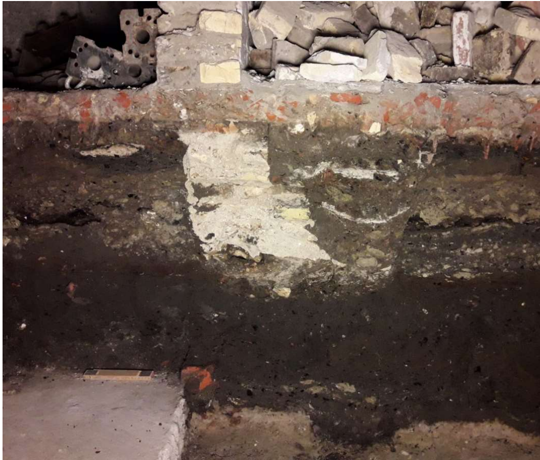
Figur 19. Eksisterende kældergulv med skillevæg samt fundering under. Foto: Københavns Museum.
