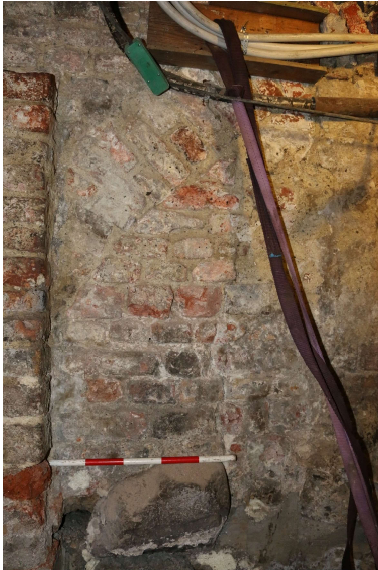
Figur 14. Aflastningsbue 2 bestående af renæssancesten set mod NV. Foto: Københavns Museum.
