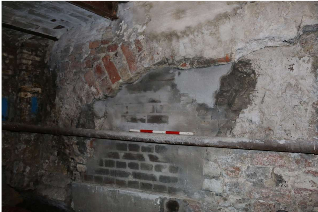
Figur 13. Aflastningsbue 1 bestående af munkesten og opmurede moderne teglsten set fra NØ. Foto: Københavns Museum.
