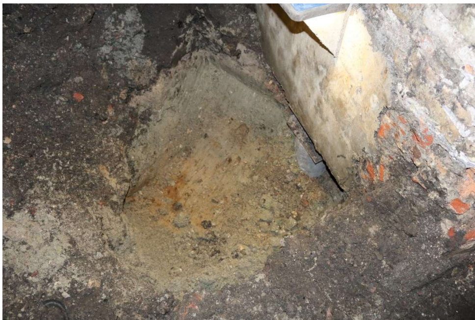
Figur 12. Blotlagt moræneler i mindre grøft i kælderrummets NV hjørne under blandet kulturlag i sammenhæng med pælefundering. Foto: Københavns Museum.
