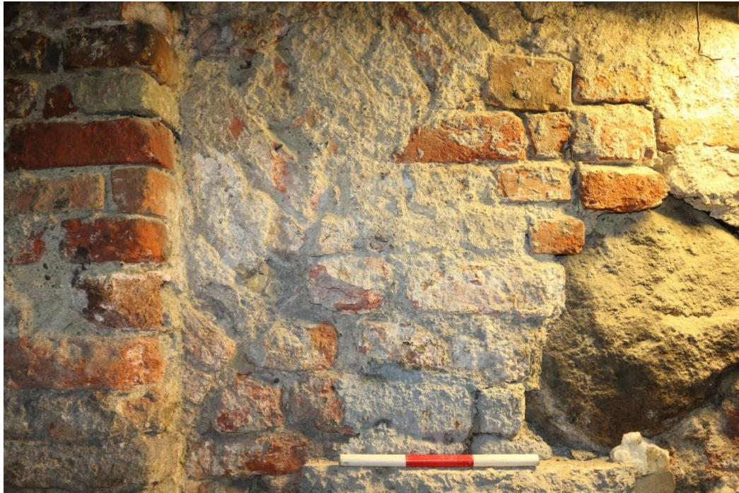
Figur 15. Bevarede dele af aflastningsbue 3 bestående uens typer af teglsten set mod NV. Foto: Københavns Museum.
