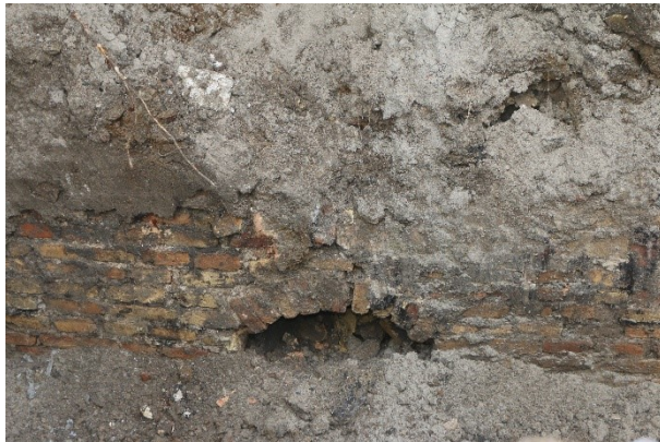
Fundament 3001 m. lille åbning i nederst i muren. Foto: Københavns Museum
