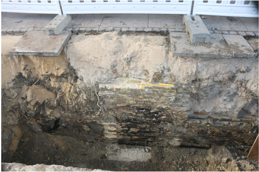
Fundament 3001. Her står murskiftet næsten helt op under den moderne belægning. Bemærk dør- eller vinduesåbning til højre i profilet. Foto: Københavns Museum
