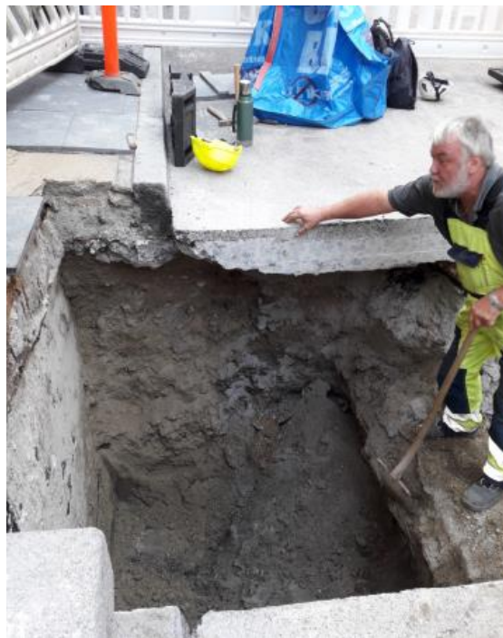
Figur 11 Felt 5 sikkerhed: Eksempel på underminering af asfalt.
