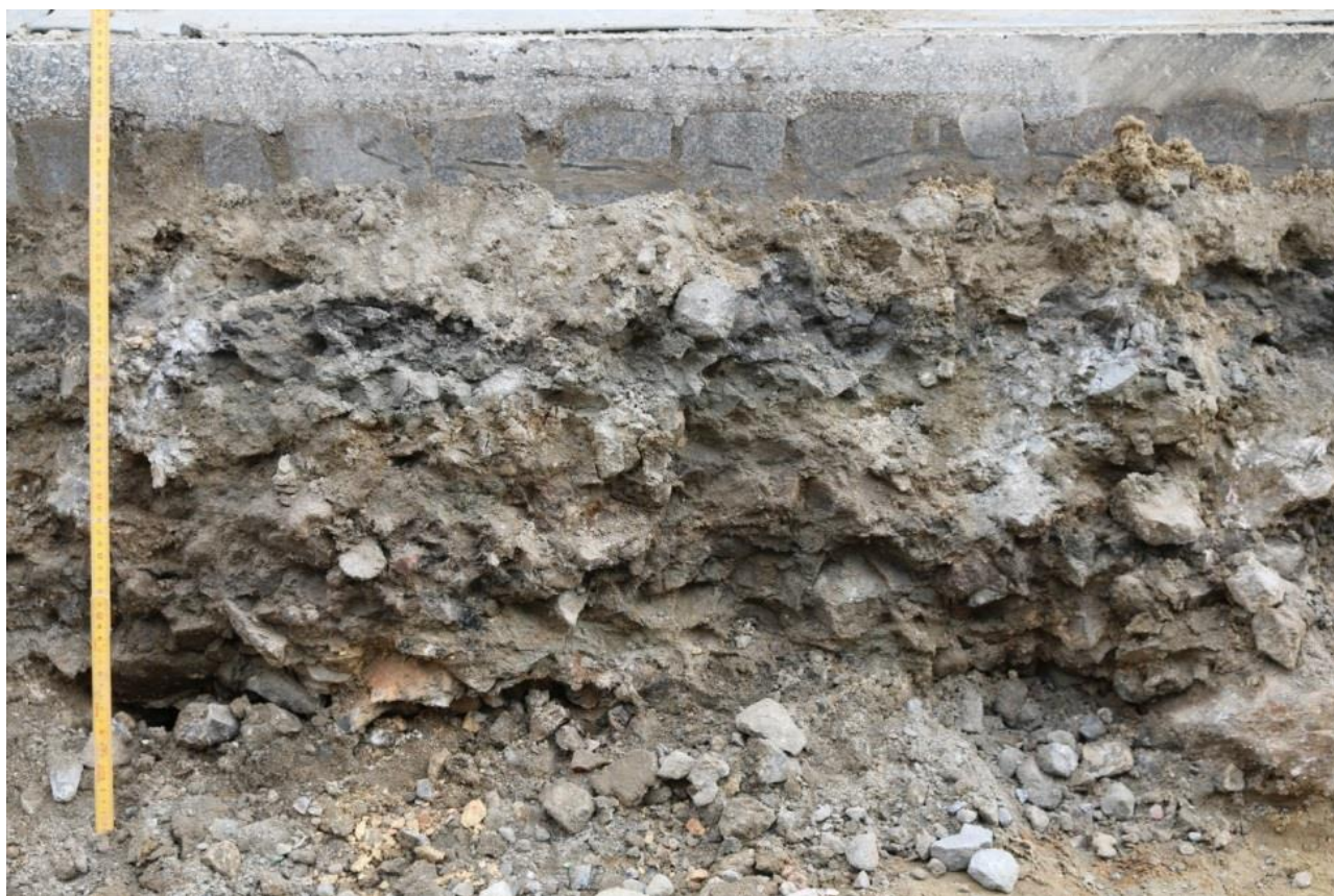
Figur 2. Refshalevejs stabilmateriale bestående av varierende sand, stabilgrus og flintskjerver sett fra øst. Foto: Københavns Museum.
