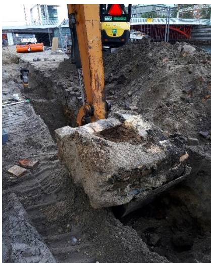
Figur 10 Det kvadratiske fundament, SS1024, løftes ud af grøften. Set mod vestsydvest.
