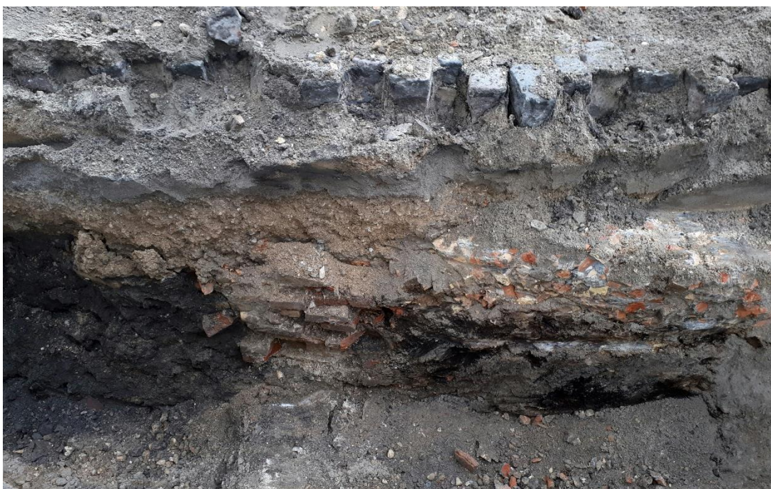
Figur 11 SS1026. Kampestensfundament skimtes i bunden af grøften, under murværket. På nordsiden af murværket set beton med teglfragmenter. Set mod nordvest.
