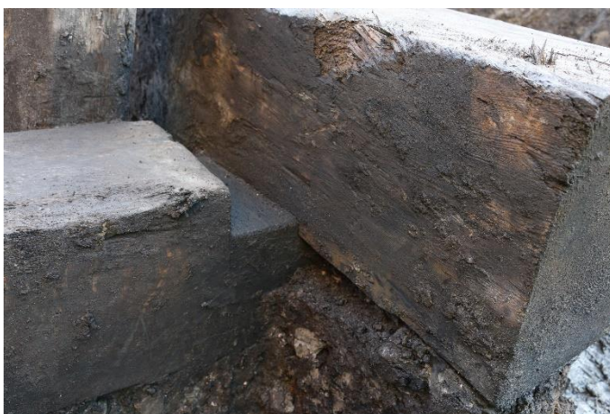
Figur 23 Ankerbjælke ST1128 og underliggende stræktømmer ST1104. Set mod Ø. IMG_2236. Københavns Museum
