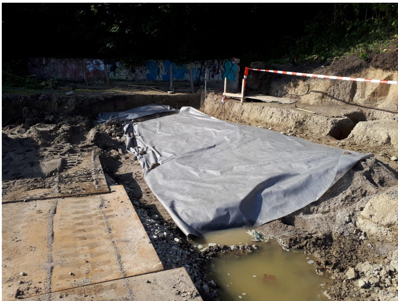
Figur 51. Tildekking av steinlegging SS1421 med fin sand og fiberduk sør for magasinbygningen sett mot SV. Foto: Københavns Museum.
