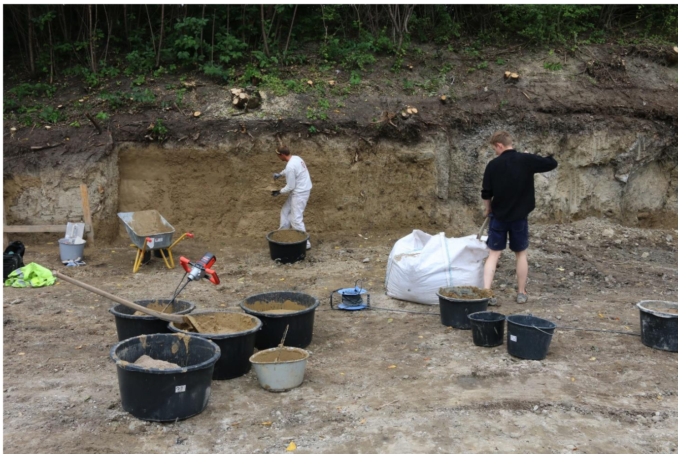
Figur 74. Påføring av kalkblandet leire på deler av den skadede vollen sett mot vest. Foto: Københavns Museum.
