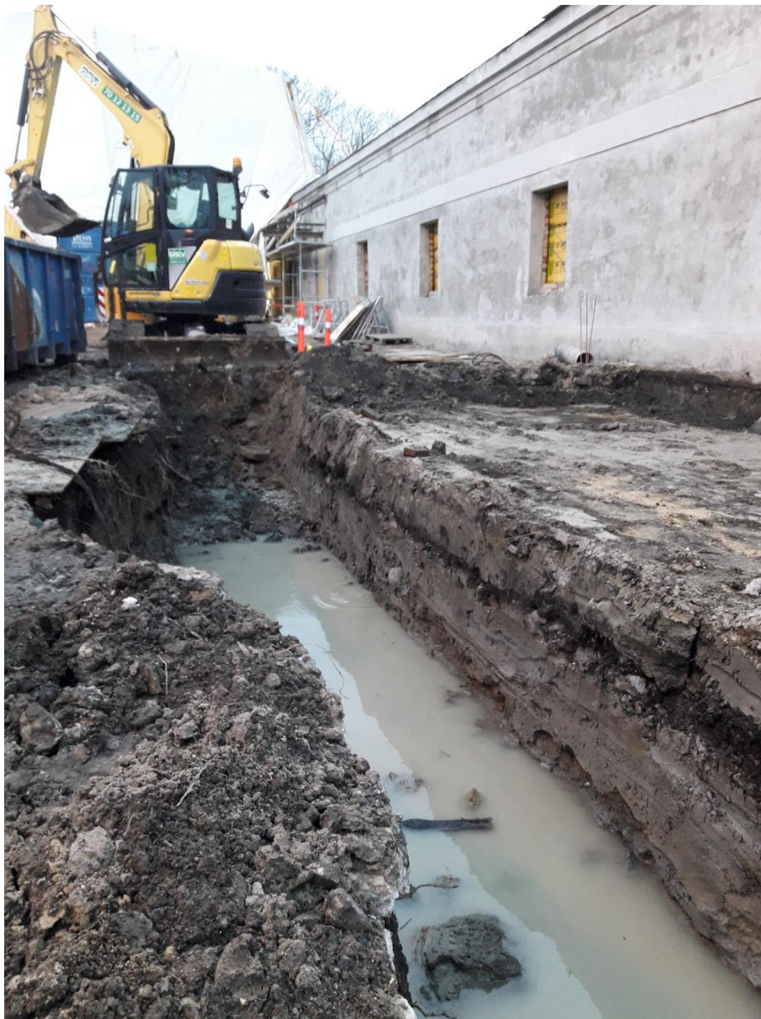
Figur 67. Grøft ZT2309. Fjerning av moderne kloakkledning med rester etter vollgravens mørke og humøse sedimentasjon SD2335 og delvis blottlagt stein i kanten tilhørende SS2351 sett mot SV. Foto: Københavns Museum.
