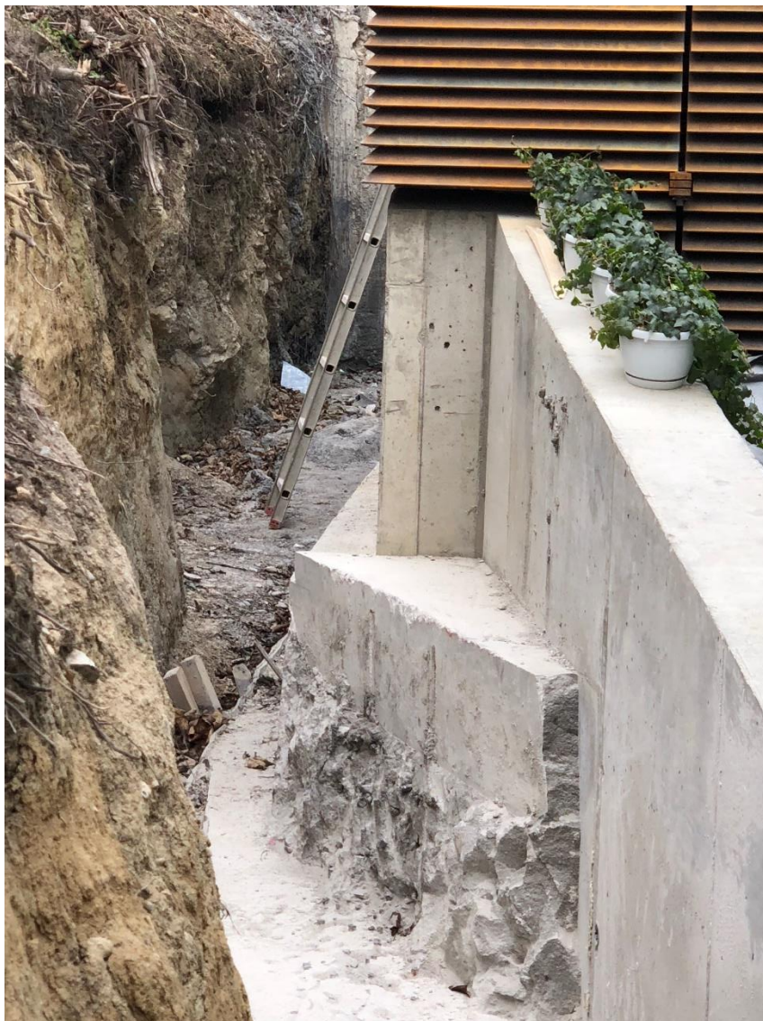
Figur 72. Fjernet betongfundament på innsiden av støttemur fotografert den 25. februar 2018 sett mot nord. Foto: Niels Thorald Rasmussen, NT Consulting ApS.
