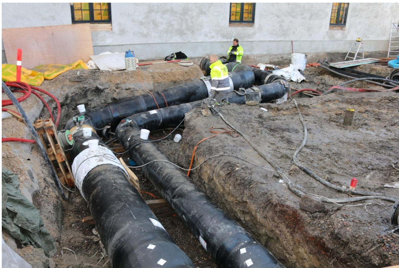
Figur 53. Grøft ZT2309 for fjernvarme sett mot vest. Foto: Københavns Museum.
