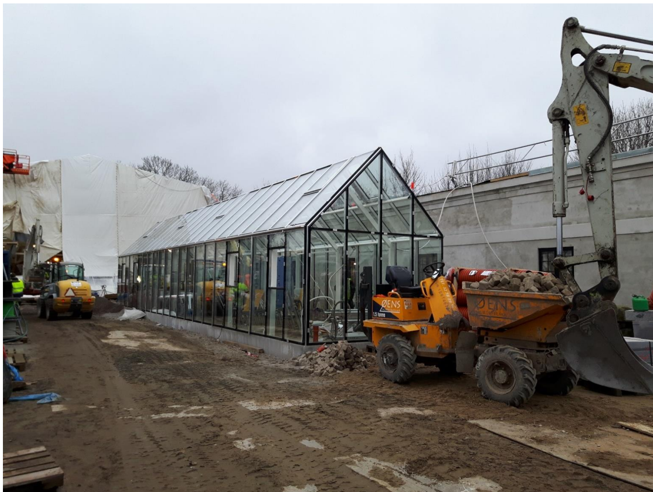
Figur 61. Oppføring av veksthus under januar 2018 sett mot SV. Foto: Københavns Museum.
