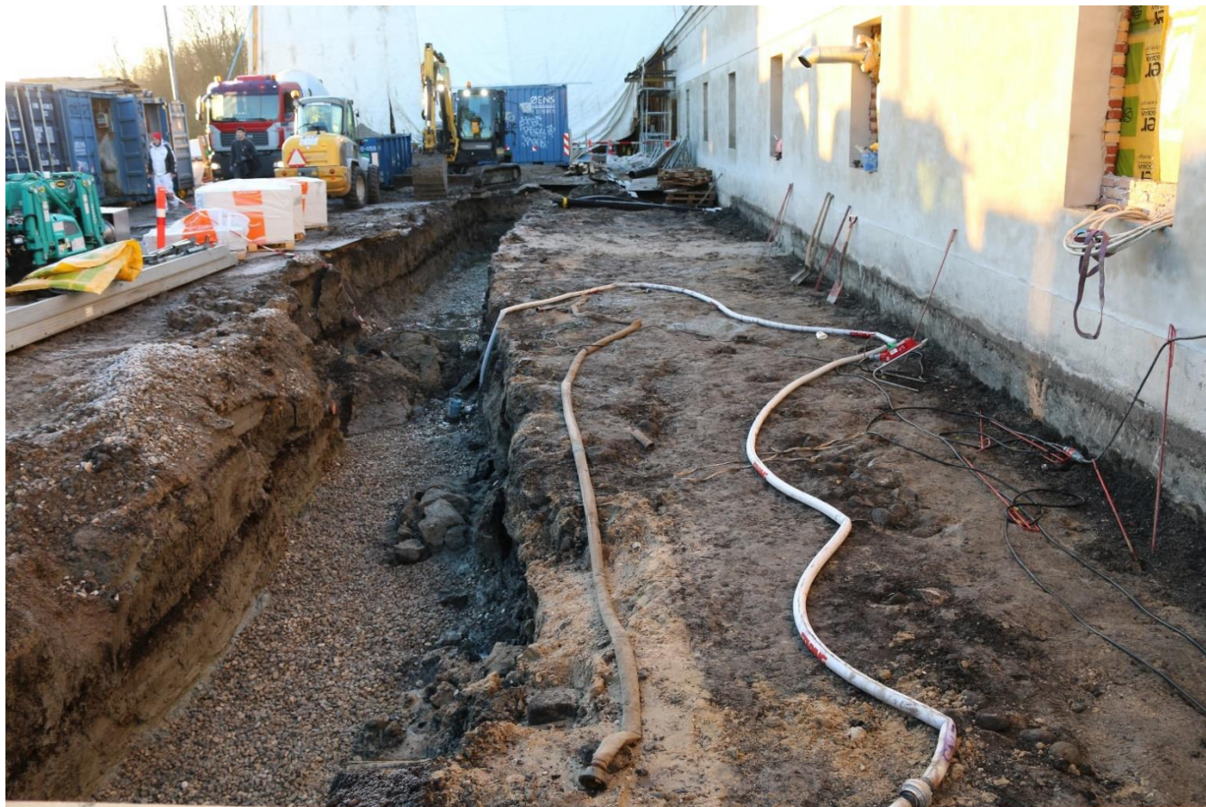
Figur 52. Oversikt over ledningstrasé (ZT2309) for kloakk, vann og fjernvarme langs med magasinbygningen sett mot sør. Foto: Københavns Museum.
