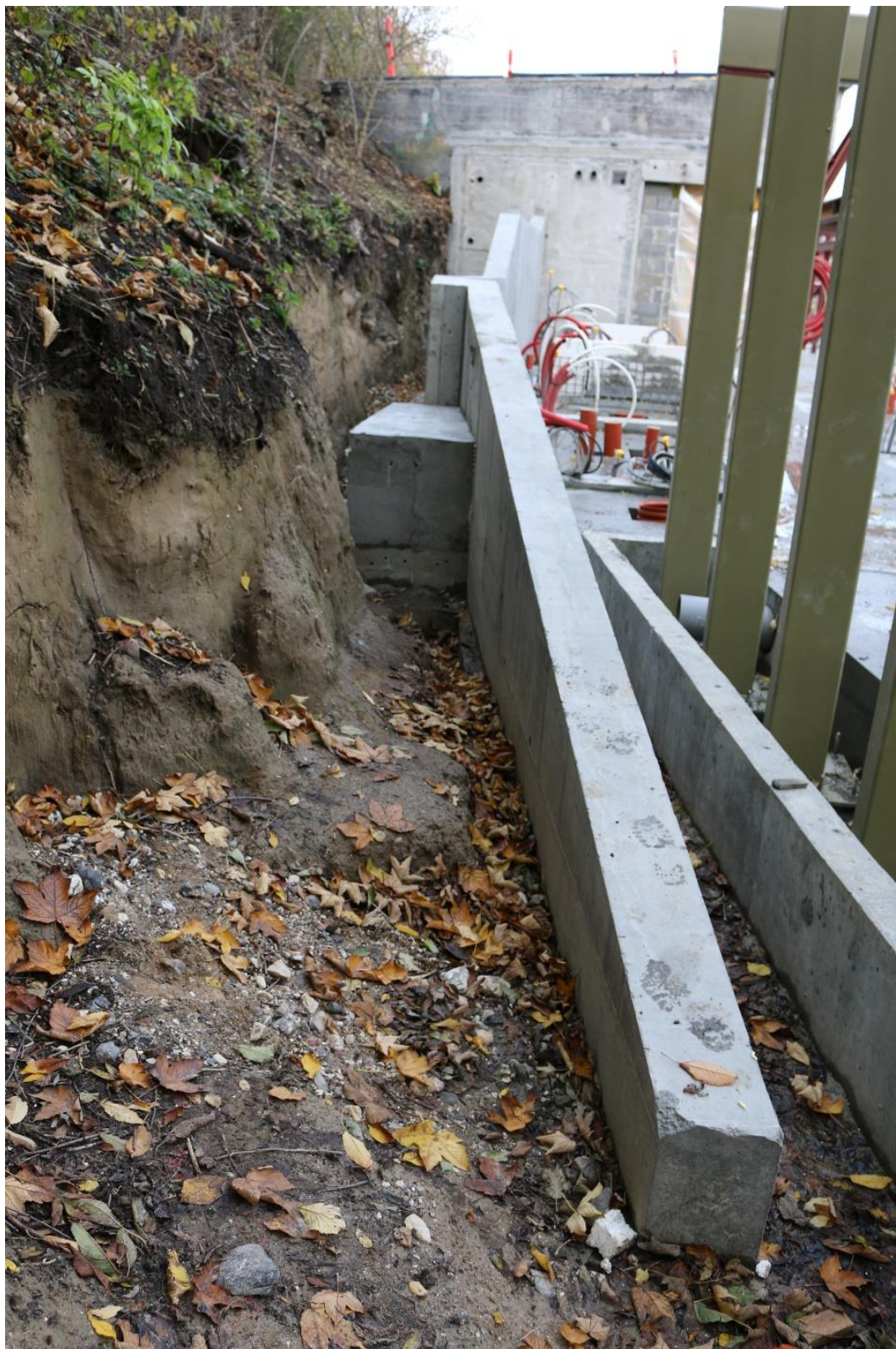
Figur 71. Feilstøpt betongfundament på innsiden av støttemur fotografert den 8. november 2017 sett mot nord. Foto: Københavns Museum.
