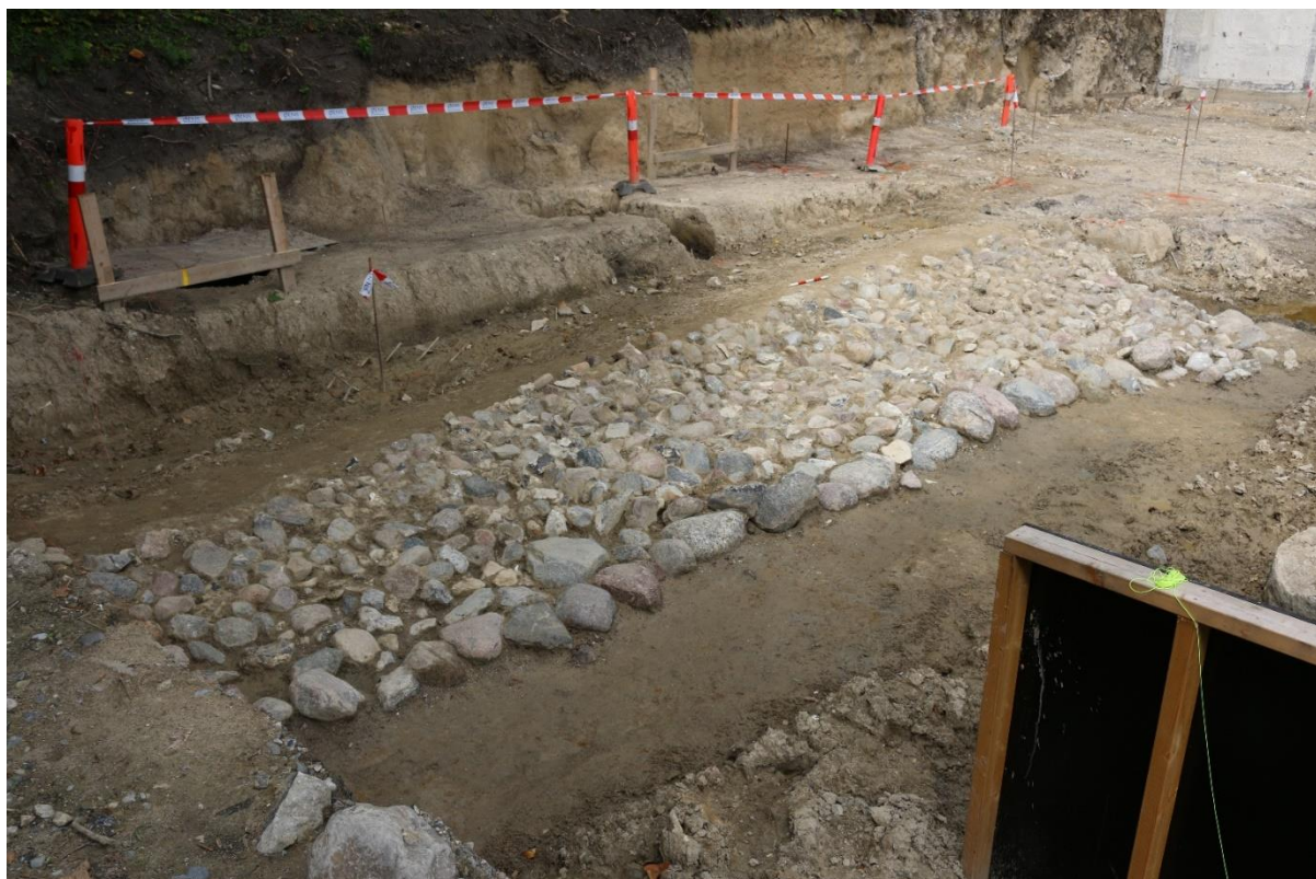
Figur 42. Steinlegging og bermeforsterkning med kantkjede av avrundede og kantete naturstein sett fra SØ. Foto: Københavns Museum.
