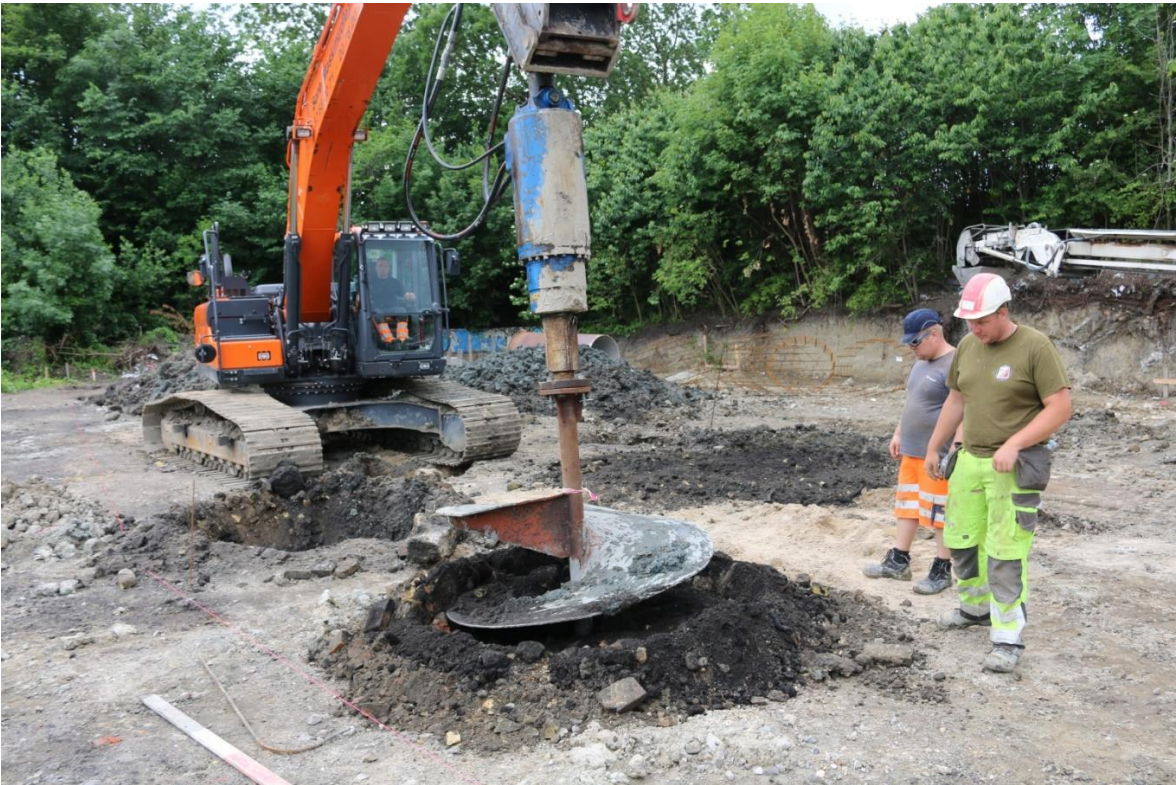
Figur 17. Punktfundamentering. Boring med sneglebor i tilslutning til magasinbygning. Foto: Københavns Museum.
