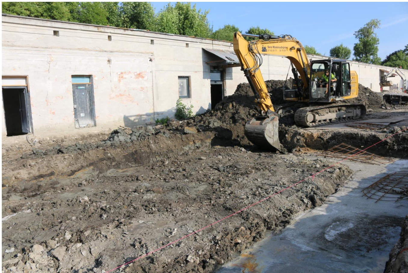
Figur 20. Graving i sammenheng med linjefundamentering og terrengtilpasning framfor Søminedepotet sett fra SØ. Foto: Københavns Museum.
