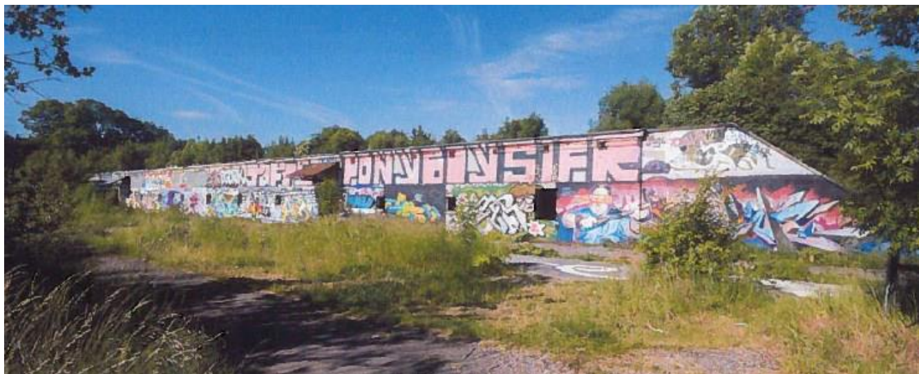
Figur 3. Søminedepotets sommeren 2016 før oppstart av anleggsarbeid sett fra nordøst. Foto: Peder Elgaard, Elgaard Architecture 2016.
