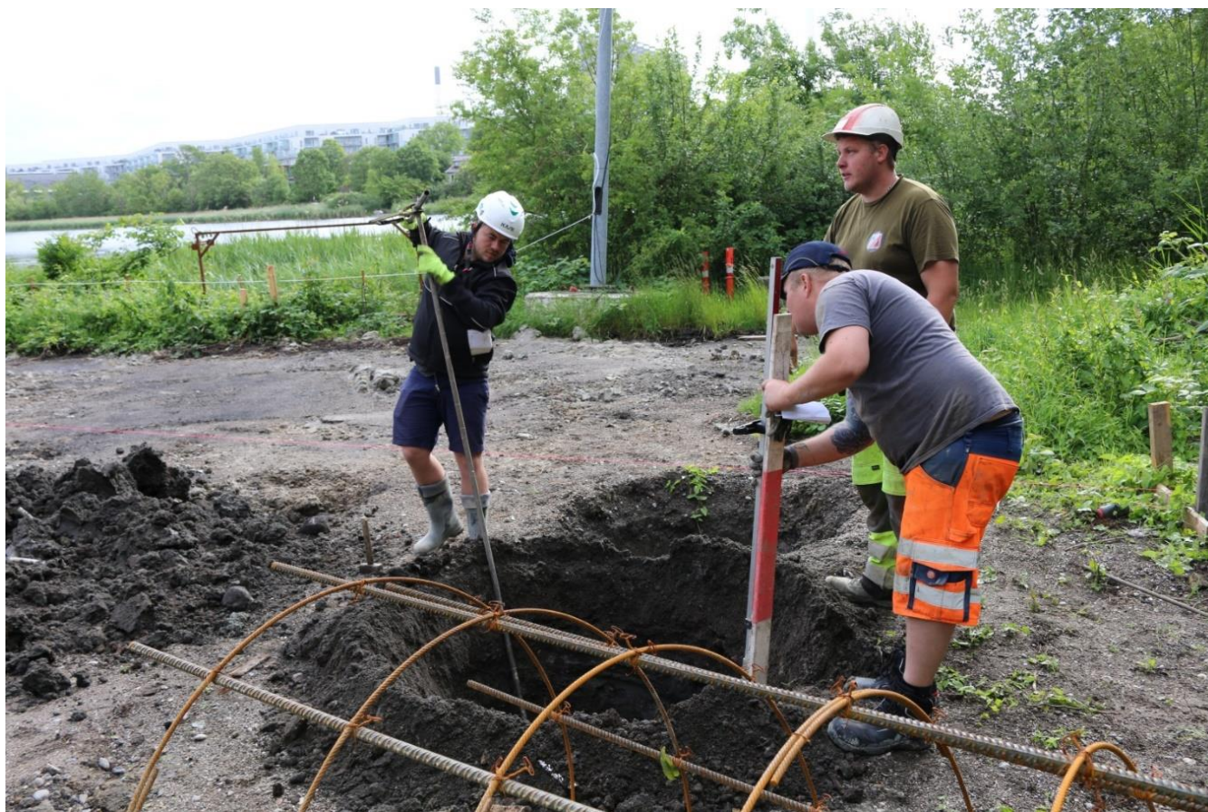
Figur 18. Dybde i fundamenteringshull oppnådd etter geologisk kontroll av moreneleire før nedsenking av armeringsjern og støpning av betong. Foto: Københavns Museum.
