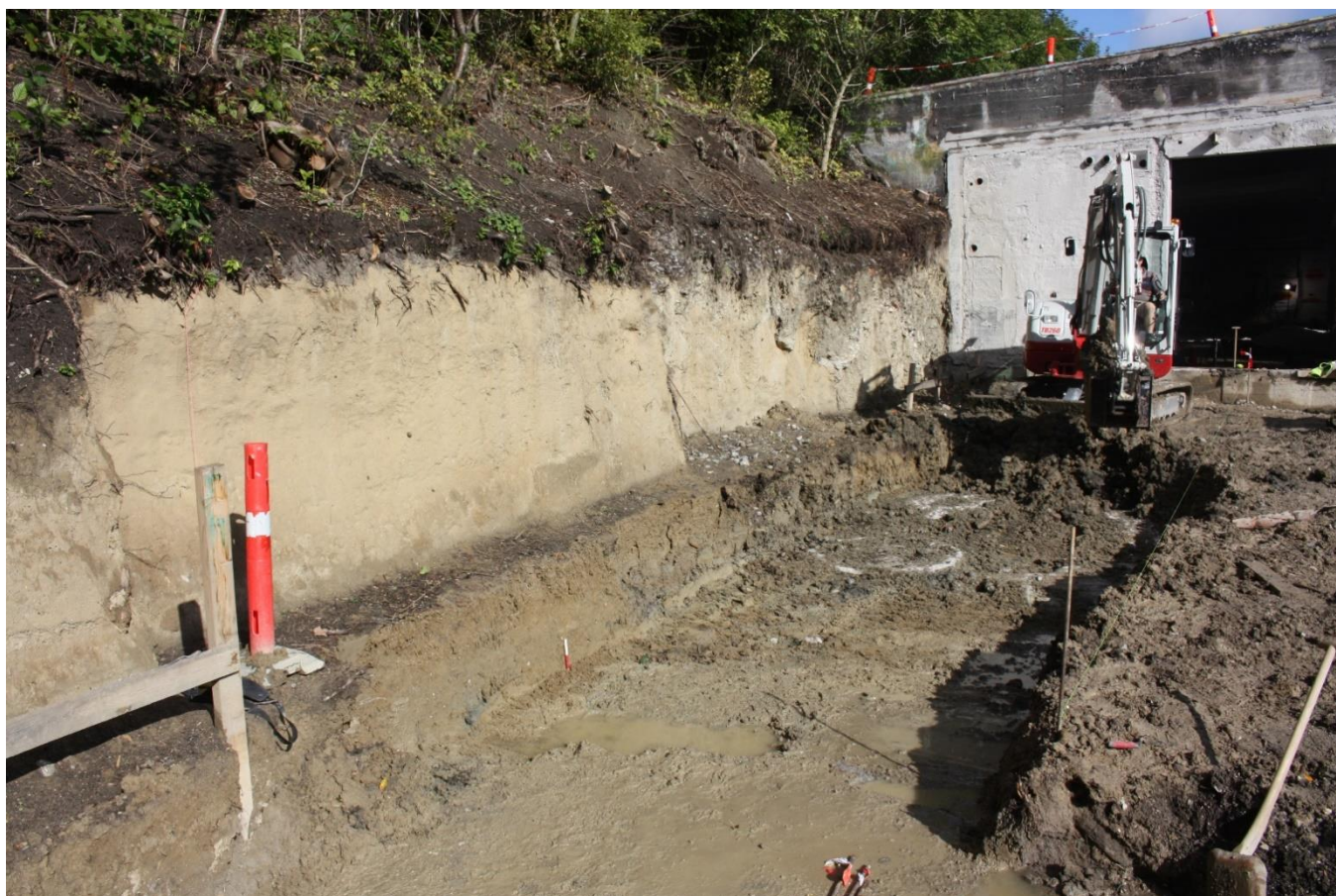
Figur 19. Grøftegraving i sammenheng med linjefundamentering langs med vollfoten sett mot NV. I enden av grøften synes støpte borehull for punktfundamenteringen. Foto: Københavns Museum.
