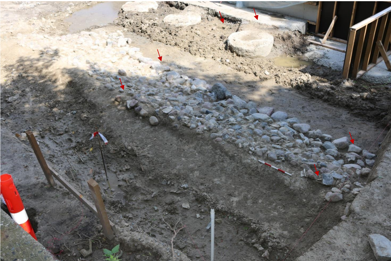
Figur 27. Oppmåling av toppkoter i steinlegging i forhold til ferdigstøpte betongfundament sett mot NØ. Foto: Københavns Museum.
