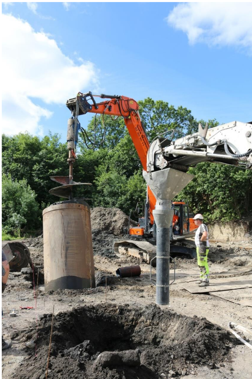
Figur 15. Punktfundamentering. Fortløpende boring og betongstøping på forplassen sett mot sør. Foto: Københavns Museum.
