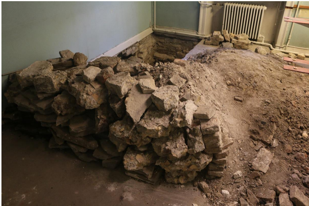
Figur 2. Udgravningen i det sydlige hjørne af rummet. Set mod øst.
