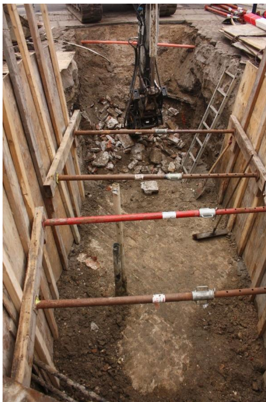
Figur 13. Gulvbelægningen set mod nordvest. Længst tilbage i grøften ses de nedbrudte rester af muren.
