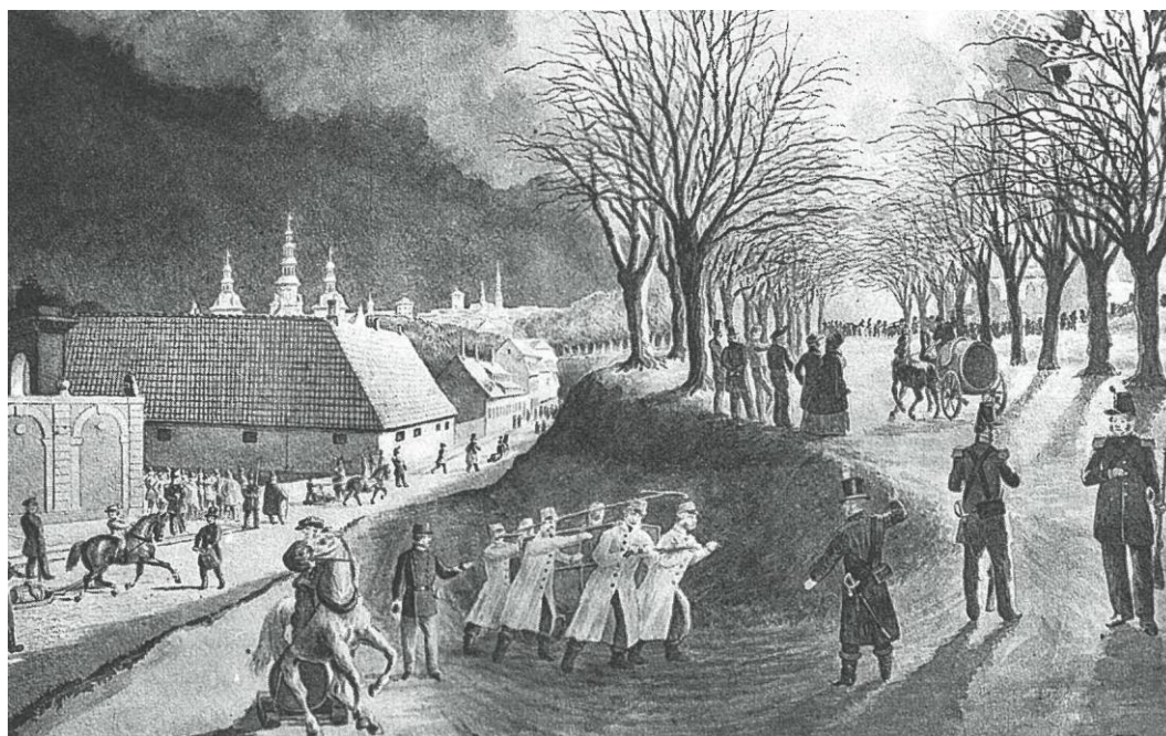
Figur 4. Blik mod sydvest. Hjørnebygningen ses centralt i billedet. Man fornemmer ret tydeligt, hvordan voldgaden er mindre end Sølvgade, men der er dog blevet plads til fortov mellem bygningerne og den stenbelagte gade. Illustration af Christian Bayer udført i 1870'erne.
