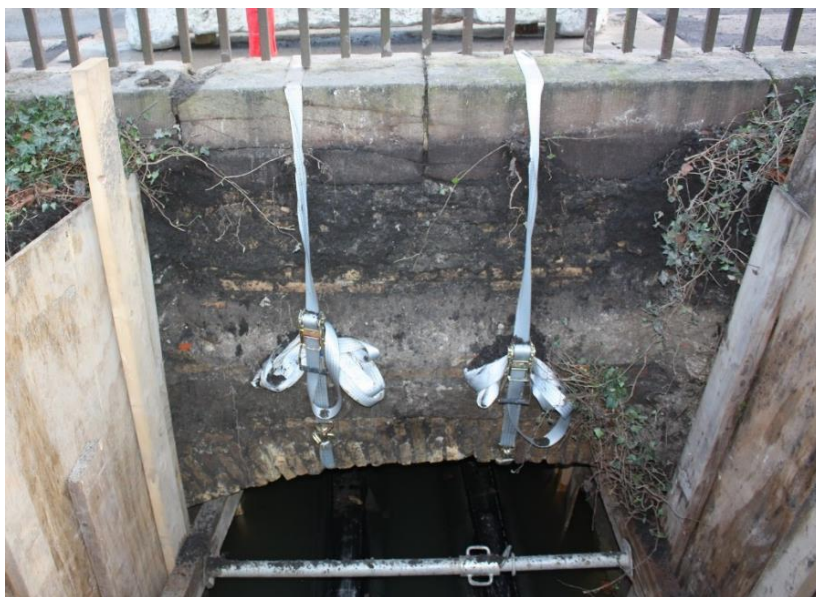
Figur 9. Fundament til gitterværket omkring Kongens Have som den fremstod i fjernvarmegrøften. Det ses hvordan fjernvarmerørene er ført under en aflastningsbue hørende til fundamentet. Fotoet er taget inde fra haven ud mod Kronprinsessegade.
