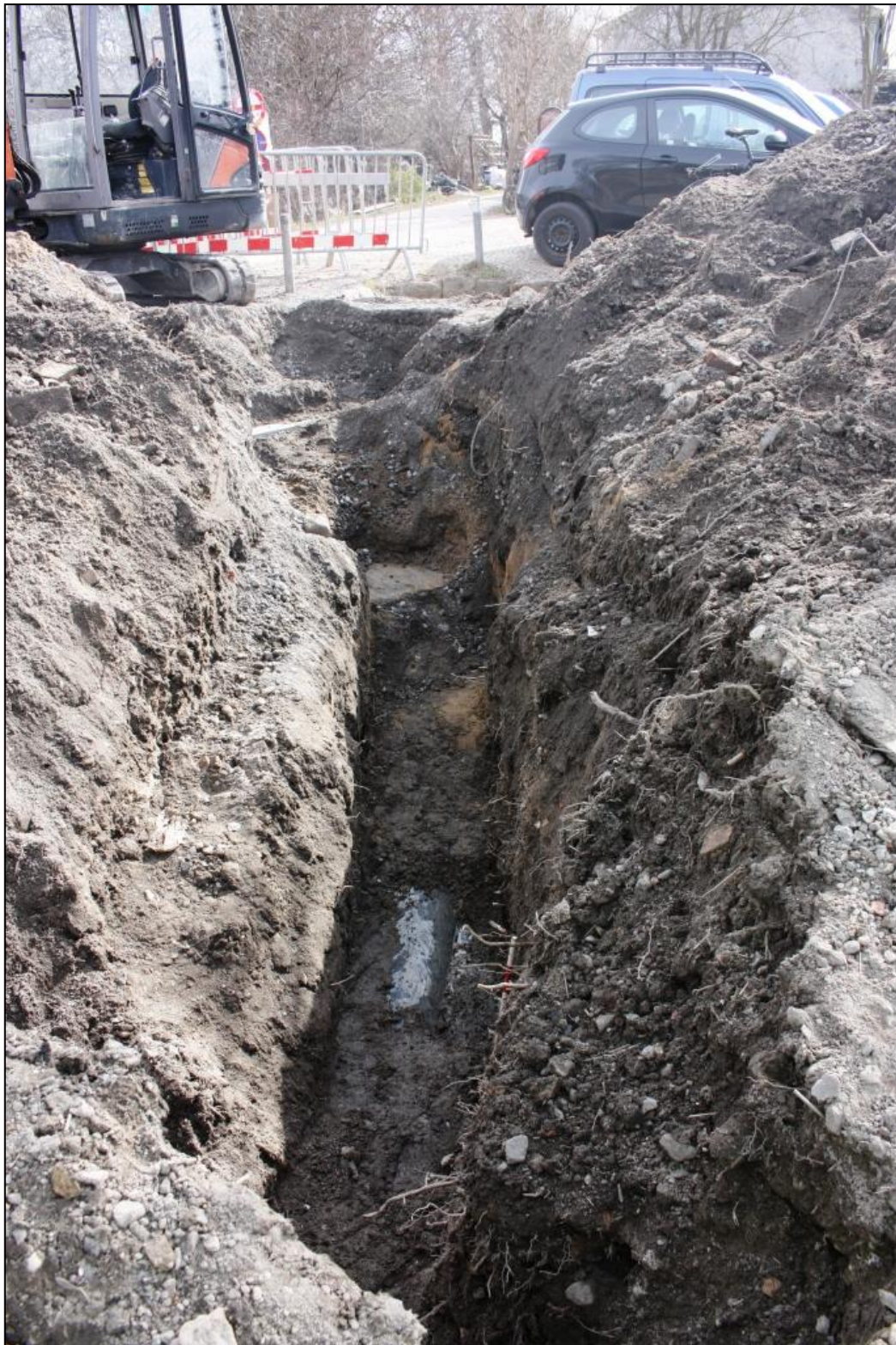
Fig. 5. Blik mod sydøst langs den genopgravede grøft. Ledningen ses delvist afdækket i bunden og længst væk i grøften ses kanten af bygværket ca. 0.5m under terræn.
