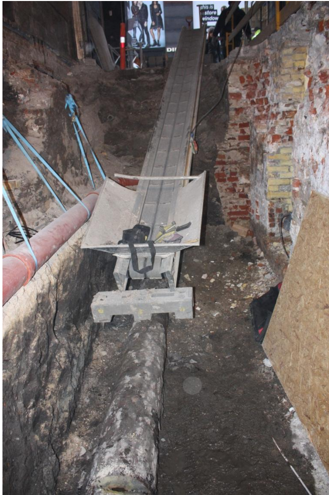
Figur 10. Blik mod Købmagergade. Nederst ses trævandreret ST100007. Til højre ses dele af den yngre teglstensmur SS100002.
