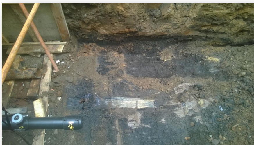
Figur 12. Anlæg 4, cirka midt i grøften forsvinder trævandrøret ned i jorden. Københavns Museum, 2015.
