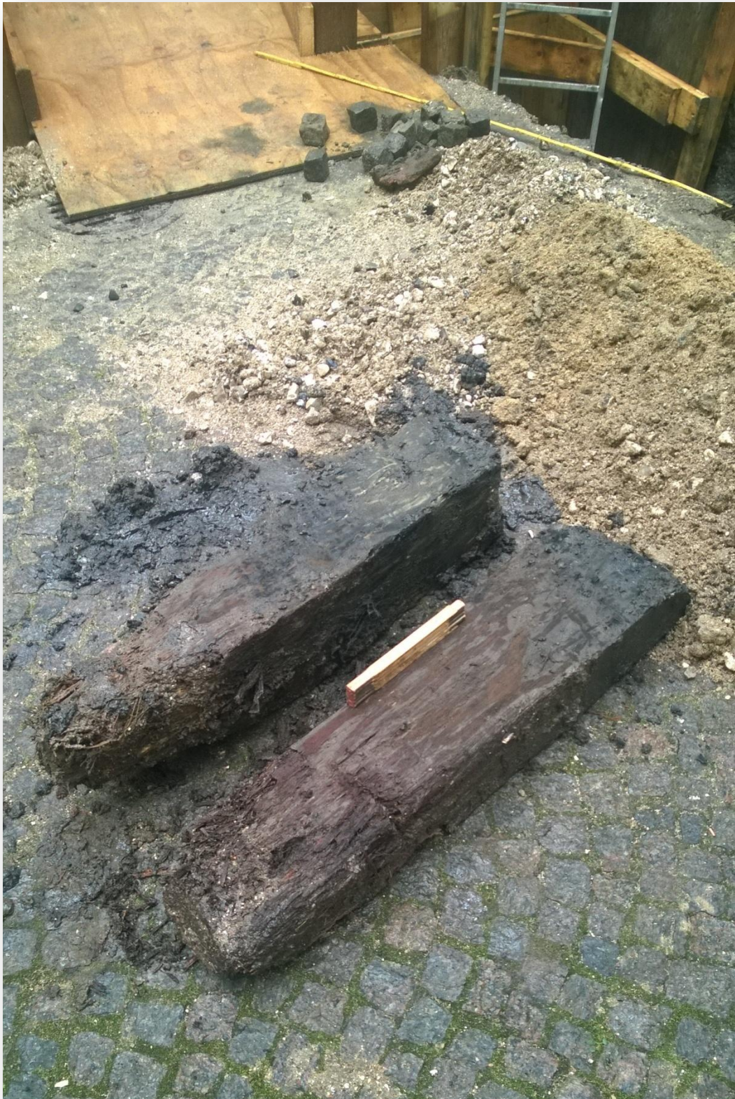
Figur 10. Pælefundering (A3). Relativt massive pælefunderinger fundet i baggården til Brolæggerstræde 11. Københavns Museum, 2015.
