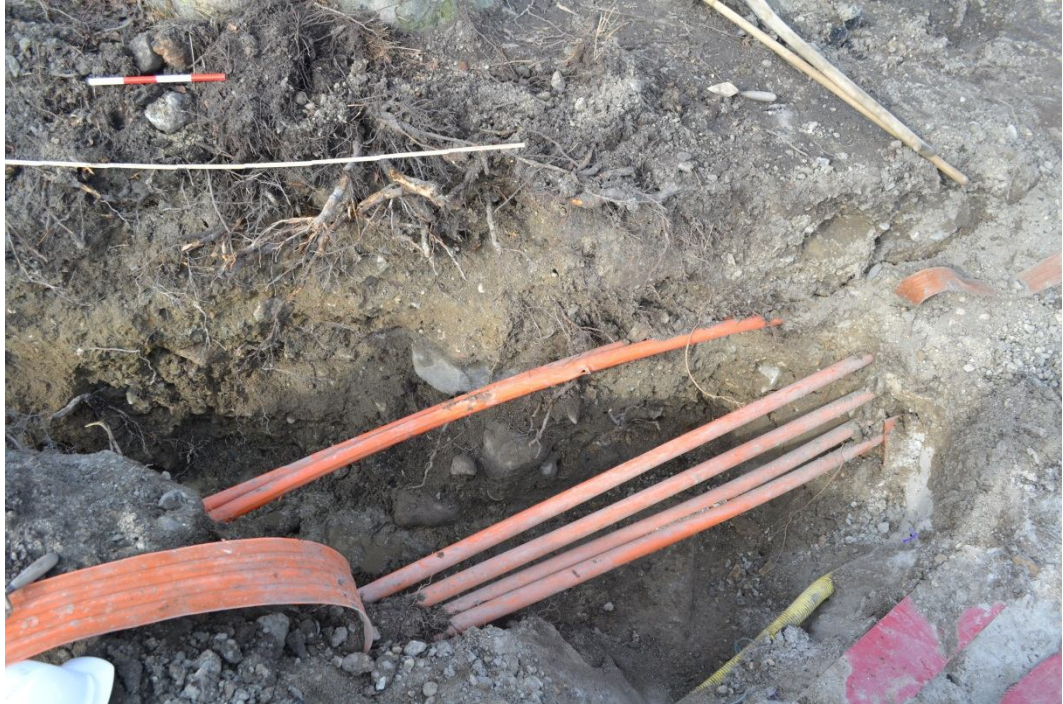
Figur 11. Foto af den vestlige profil af anlæg 1145. Bemærk stenene in situ i bunden af tracéet (foto: Karen Green Therkelsen).
