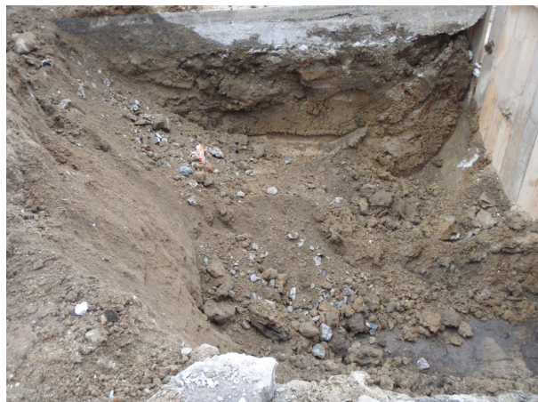
Figur 7. Lag A4 under udgravning.
