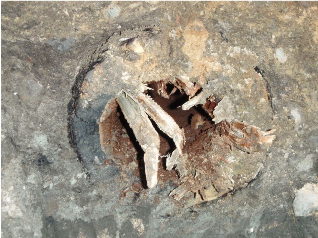
Figur 6. Trævandrør A2 efter gennemgravning.
