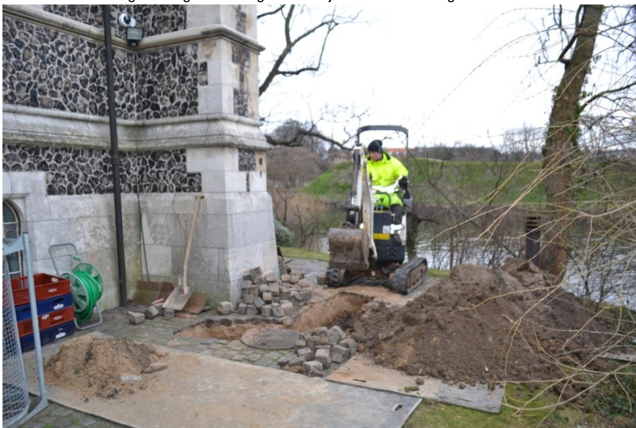
Figur 6. Arbejdsfoto. Opgravning ved brønd på nordsiden af kirken. Foto: DSC_3596
