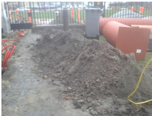
Figur 8. Den opgravede jord rodes igennem for eventuelle fund inden det fyldes i traceet igen. Foto: 20140116_085324
