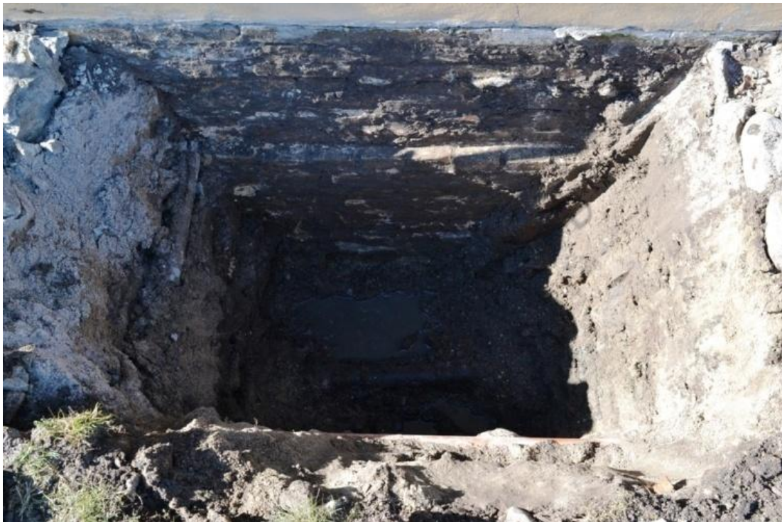
Figur 9. Teglstensfundament under tilbygningen til Kommandantgården.
