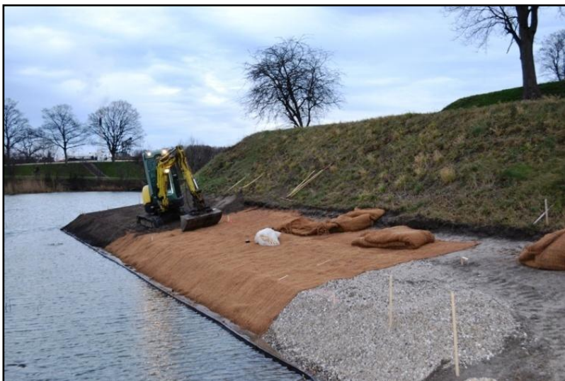
Figur 5. Der udlægges ral og biologisk nedbrydeligt net før der påføres ny muldjord og sås græs.
