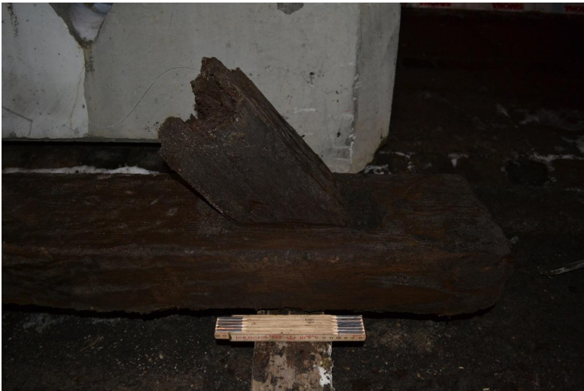
Figur 14. Detalje fra trækonstruktion 100010. Her ses et af de skråt stillede "ben".
