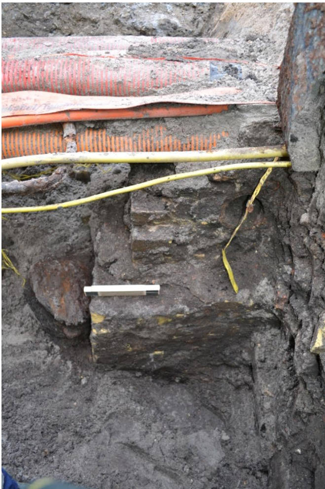
Figur 12. Fundament 100008 samt træplanke 100007
