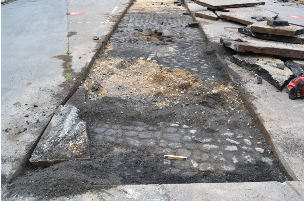
Figur 5 Brolægningen 100007 lå lige under asfalten
