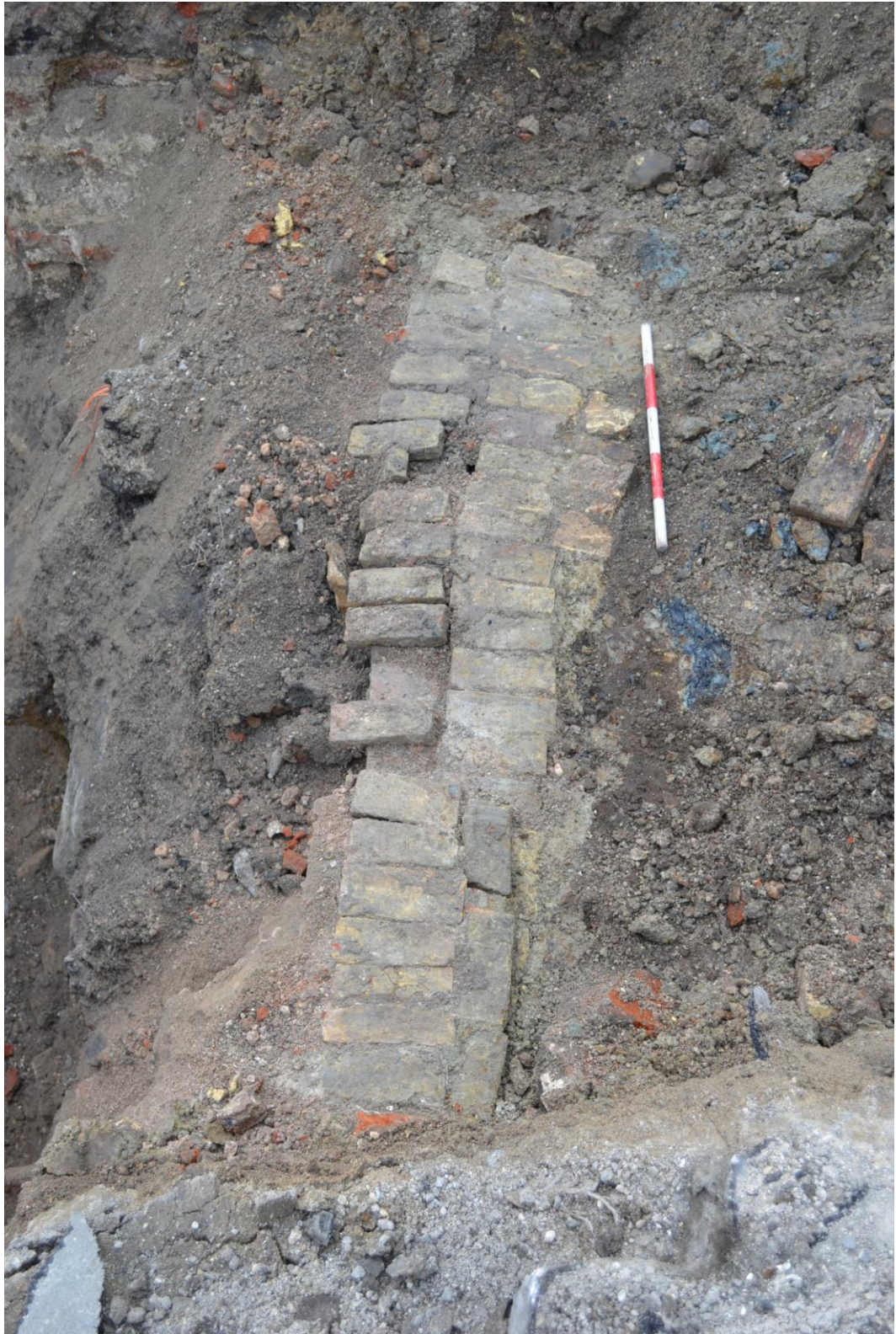
Figur 31. Højbro Plads. Del av tegelbyggnad S116, möjligen del av trappa. Foto från norr: Claes Hadevik.
