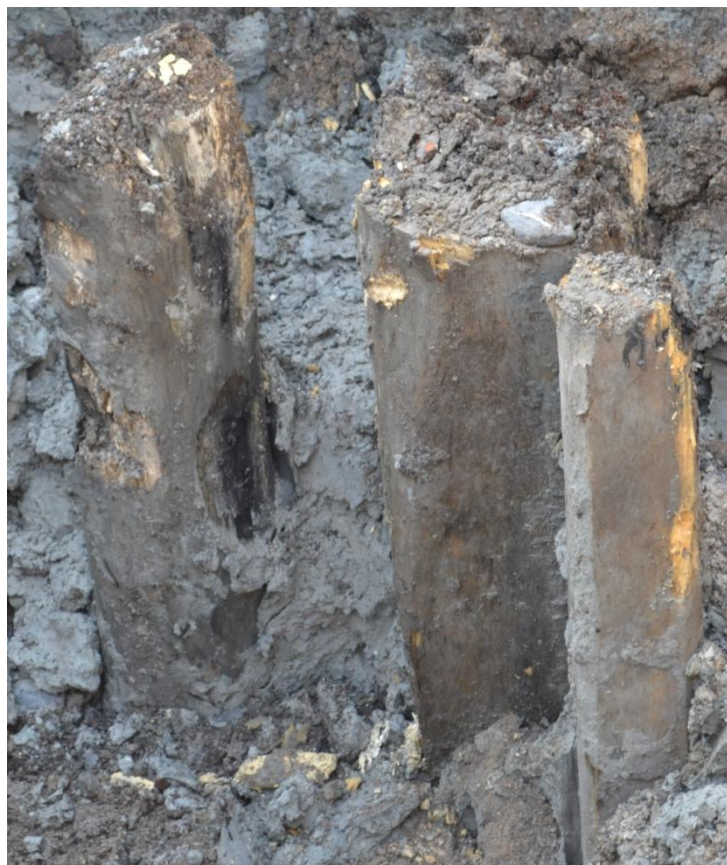
T.v.: Bolværkspæle med påliggende plænke. Foto: Andreas Bonde Hansen. T.h.: Bolværkskonstruktion med 'udskiftningspæl'. Foto: Andreas Bonde Hansen.
