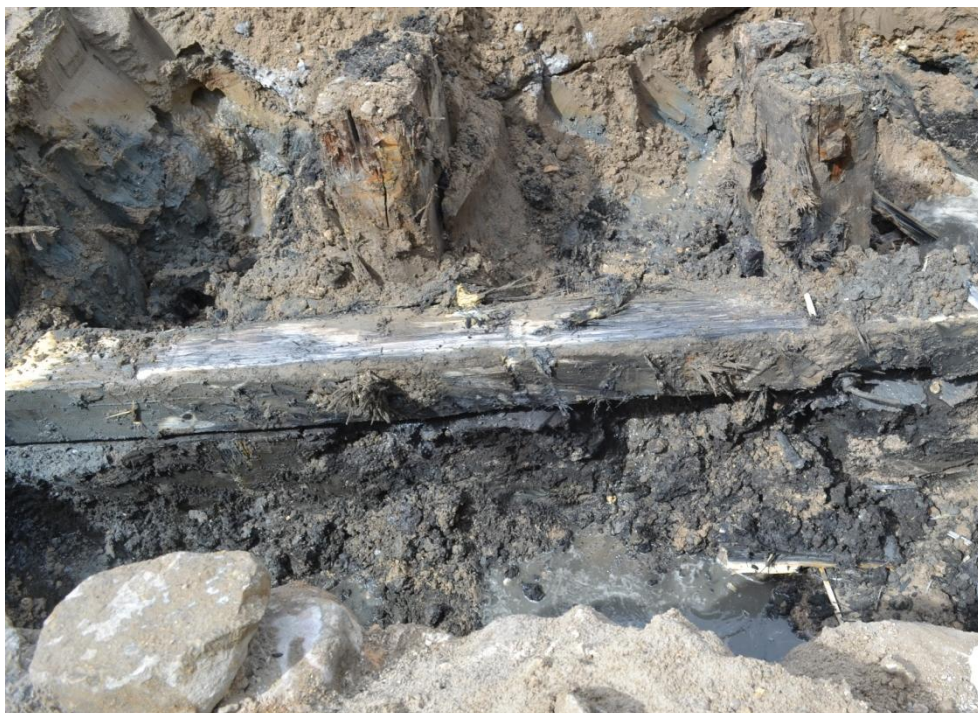
Ovenfor ses bolværk fra Islands Plads. Nedenfor ses profil af træ- og stenfundament, Islands Plads. Foto: Andreas Bonde Hansen.
