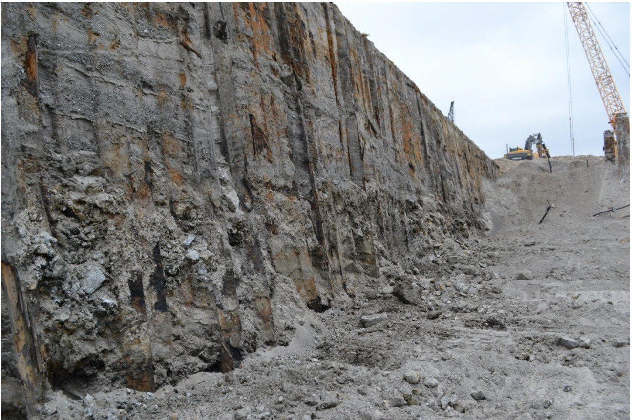
Figur 16 Bolværket fra 1876, set mod nordvest. Til højre i billedet ses det i 1938 indpumpede sand. Københavns Museum, 2014.
