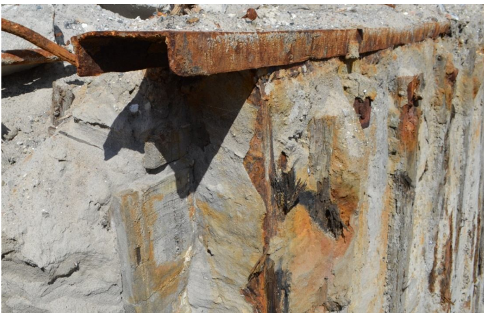
Figur 17 Langs kajkanten løb der et kontinuerligt hammerbånd af metal, som fastholdt pælene i deres position. Københavns Museum, 2014.
