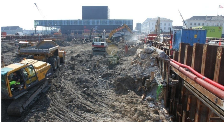
Figur 9 Et blik over udgravningens dimensioner og de mange maskiner der kontinuerligt bevægede sig rundt på pladsen. Københavns Museum, 2014
