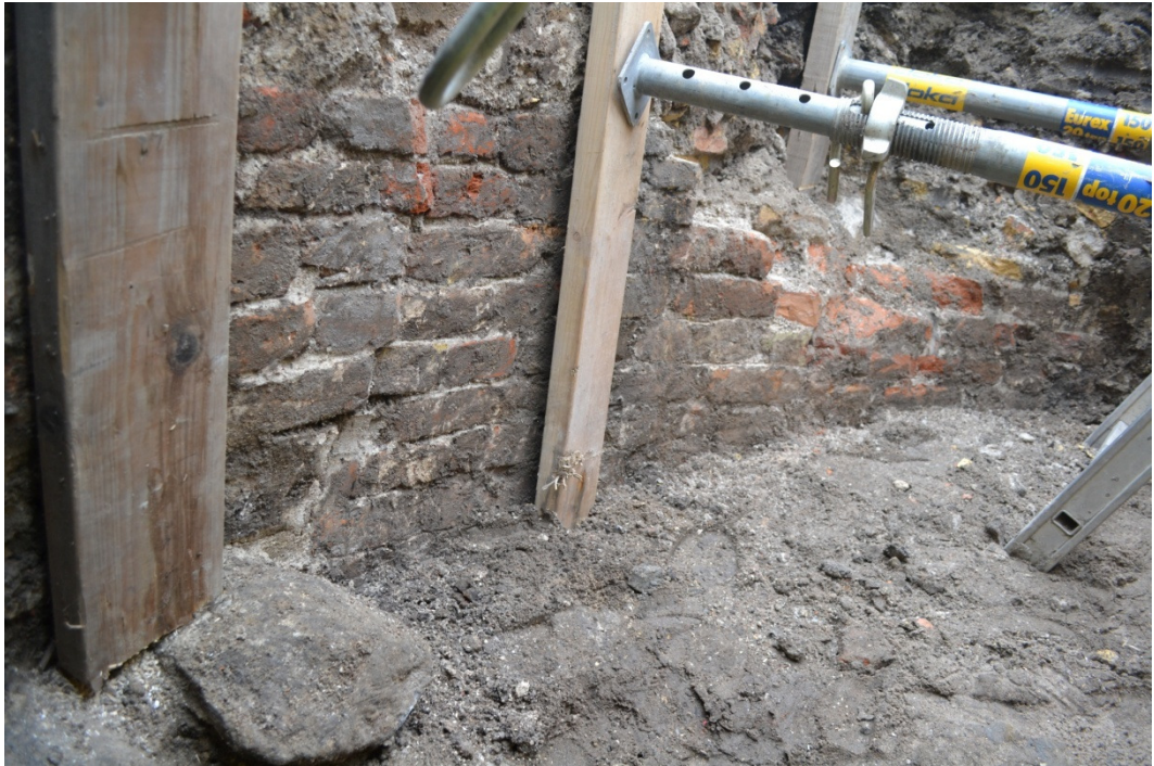
Fig. 10. Anlæg A, Landemærket. Foto: Københavns Museum.
