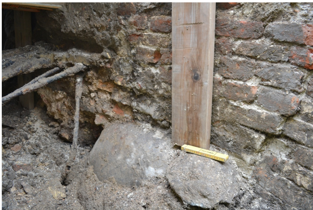
Fig. 9. Anlæg A, på Trinitatis kirkens gamle matrikel. Muren er funderet på kampesten. De nederste 5 skifter er sat i munkesten, de skifter øverste er en blanding af munkesten og hollandsk renæssanceteglsten. Til venstre i billedet kan anes en sort vertikalløbende brandlag. Foto: Københavns Museum.
