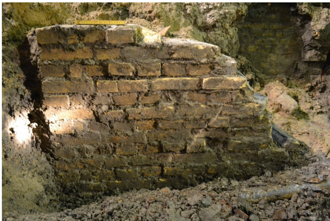
Fig. 7. Anlæg C. Hjørnet af Købmagergade og Krystalgade. Forrest ses den sydlige mur, mens den parallelt løbende mur i den nordlige profil ses øverst til højre i billedet. Begge mure er sat i krydsforbandt og består udelukkende af gule teglsten. Der løber en forbindende mur (nord - syd) imellem de to mure, hvorved de tre murforløb danner et rum, højest sandsynligt en kælder. Foto: Københavns Museum.
