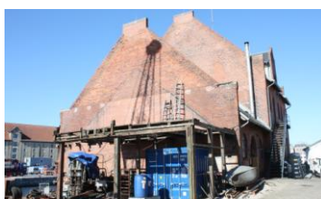
Kedel og Maskinhus fra 1909.
