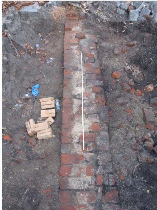
Figur 5: Den oprensede kirkemur, som danner base for den nye mur til granitblokkene
